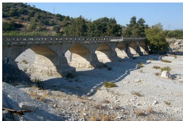
Η Γέφυρα Λουτάνη πριν την κατάρρευση
