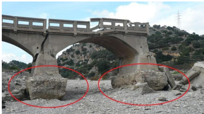
Λουτάνης – Αποκάλυψη θεμελίων 2
