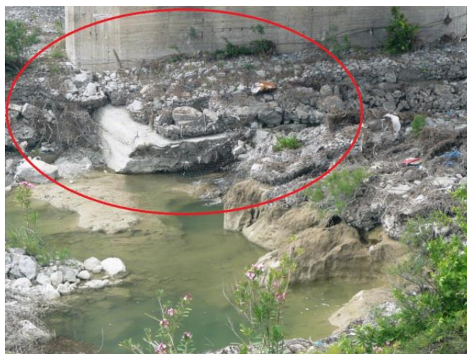
Γέφυρα Γαδουρά – λεπτομέρεια
