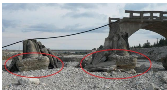
Λουτάνης – Αποκάλυψη θεμελίων 1
