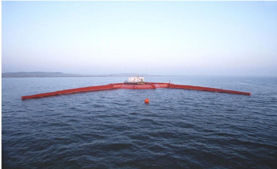
Εικόνα 24: Μέθοδος WaveDragon (πηγή: Max – Planck – Institut fur Plasmaphysik, www2.ipp.mpg.de )
