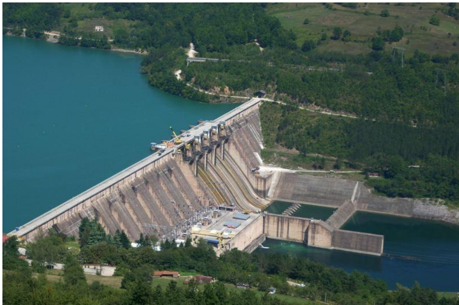
Εικόνα 32: Μεγάλο υδροηλεκτρικό εργοστάσιο στην Βόρεια Μακεδονία (πηγή: Linkedin – Κοινοπραξία ΔΕΗ – ARCHIRODON, linkedin.com )
