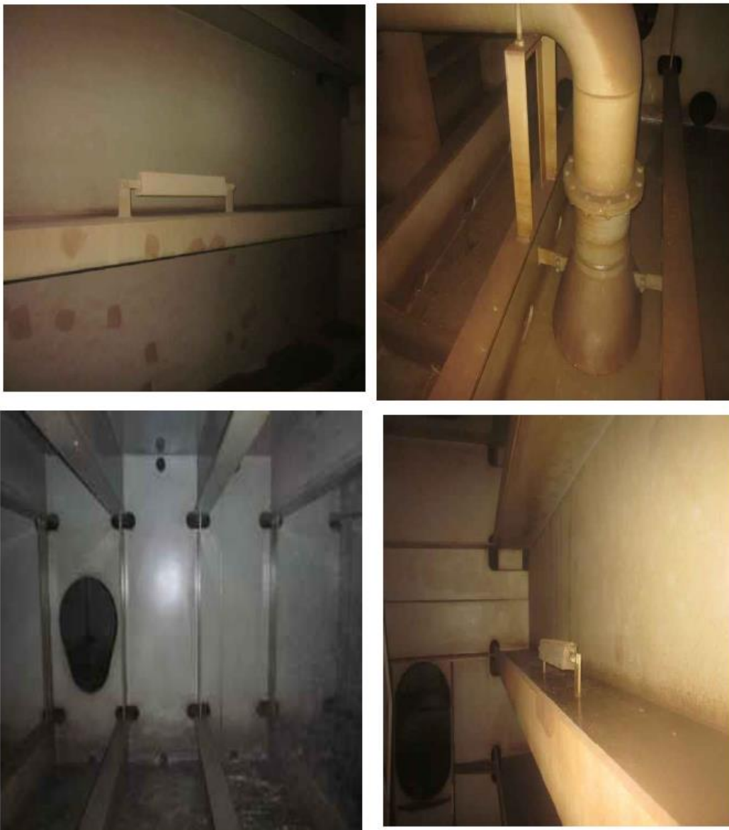
Εικόνα 16. WBT No. 2 Starboard Side, Provided by Seatec S.A.
