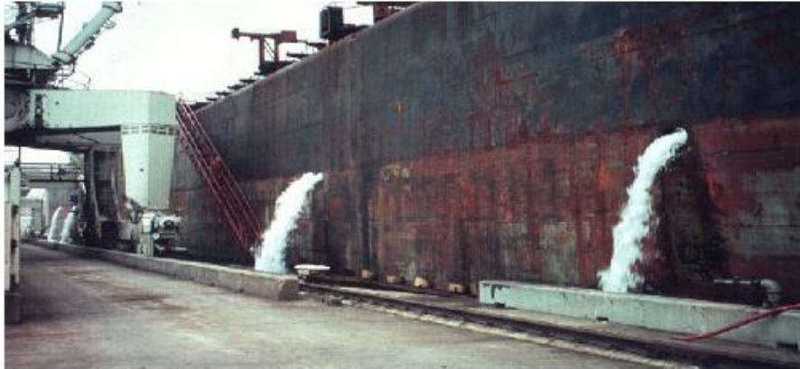
Εικόνα 2. Bulk carrier discharging topside tanks.
