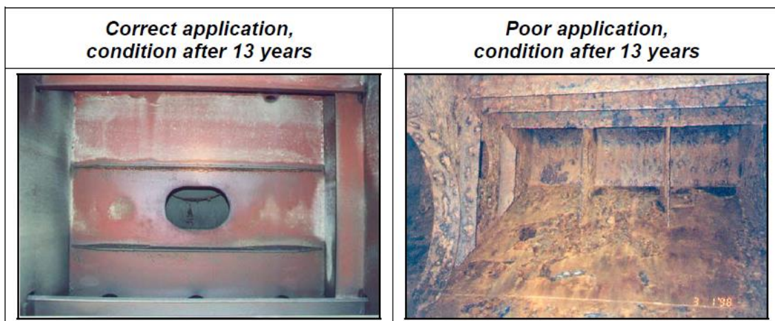
Εικόνα 11. Κατάσταση διάβρωσης δεξαμεμών έρματος πλοίων με την ίδια ηλικία.
