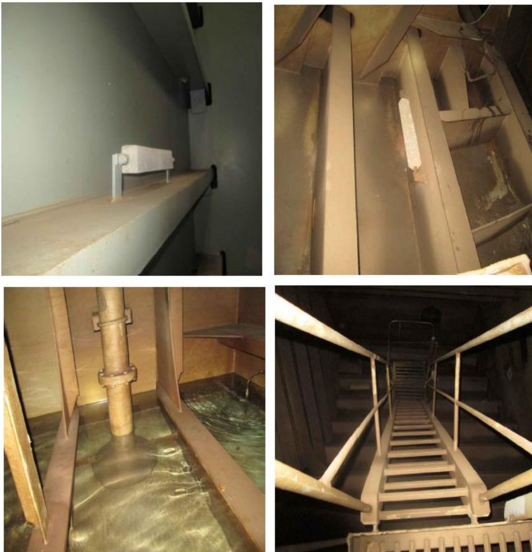
Εικόνα 24. WBT No. 6 Starboard Side. Provided by Seatec S.A.
