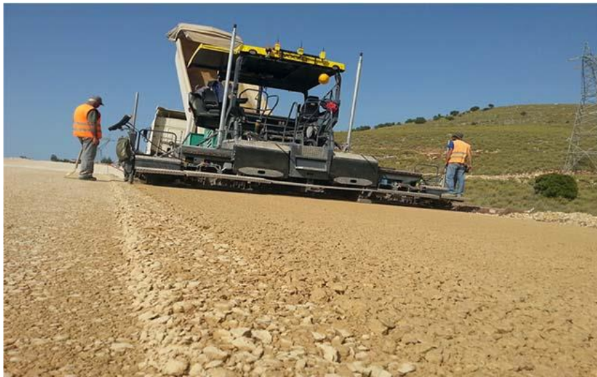
Εικόνα 73:Finisher με σύστημα 3D
