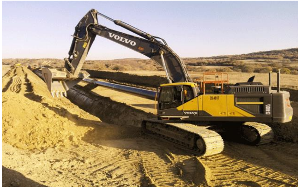
Εικόνα 52:Εκσκαφέας Volvo με Dual GNSS 3D System
