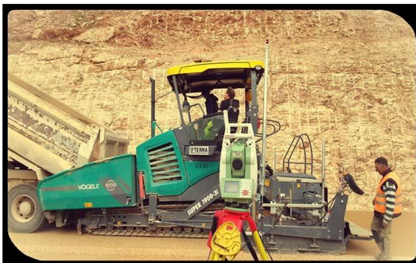
Εικόνα 71:Finisher με 3D σύστημα διάστρωσης
