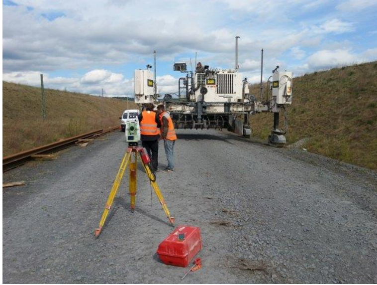
Εικόνα 78:Ρομποτικός σταθμός σε κρασπεδομηχανή
