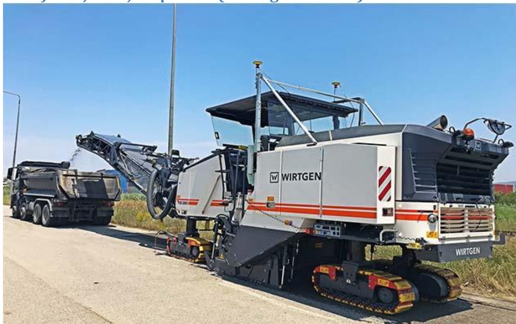
Εικόνα 14: Αποξέστης ασφάλτου(Φρέζα) με εγκατεστημένο σύστημα 3D ( https://www.wirtgen-group.com/en-us/news-and-media/wirtgen/job-report-w-210i-oakland-airport/ )
