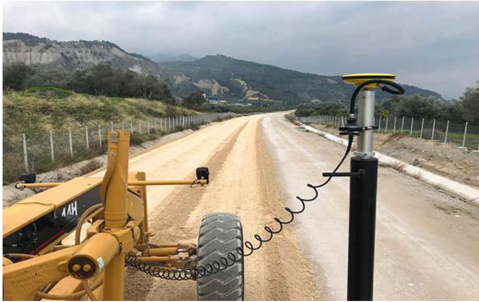
Εικόνα 54: Ιστός συστήματος με GPS antenna
