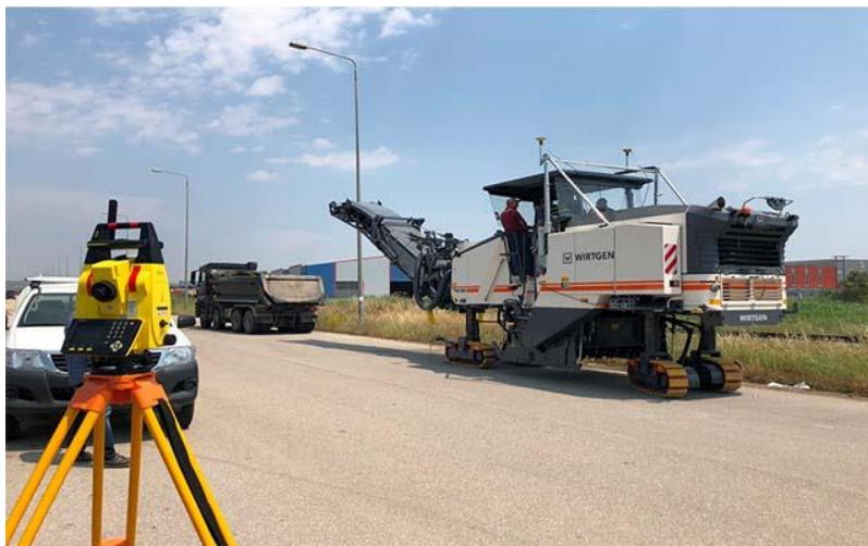
Εικόνα 65: Wirtgen Φρεζα με συστημα 3D
