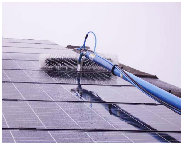
Σχήμα 2.4: Καθαρισμός φωτοβολταϊκών πλαισίων
