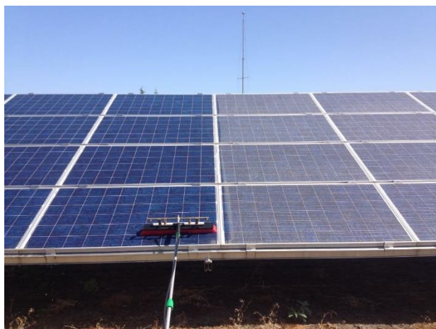
Σχήμα 2.4: Καθαρισμός φωτοβολταϊκών πλαισίων
