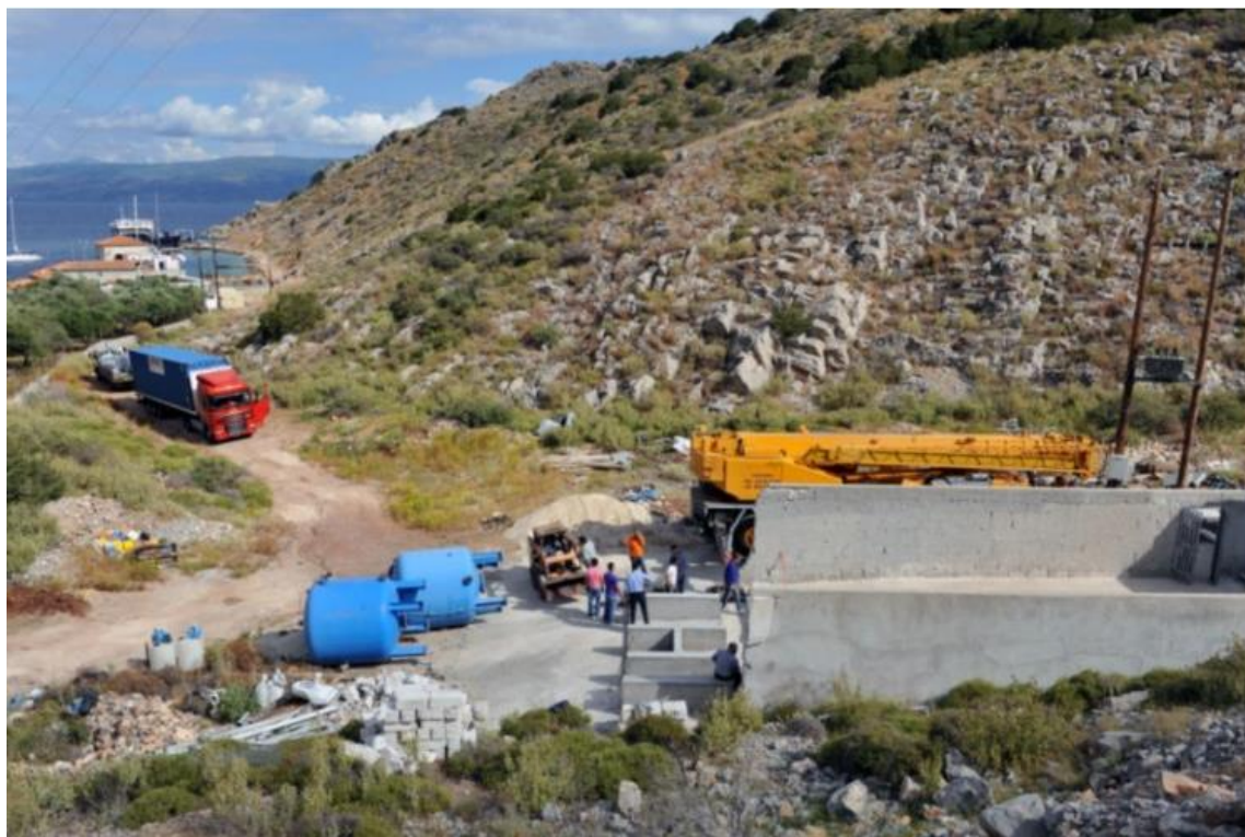
Εικόνα 3.14 Εργασίες κατά την κατασκευή της εγκατάστασης στο Μανδράκι
