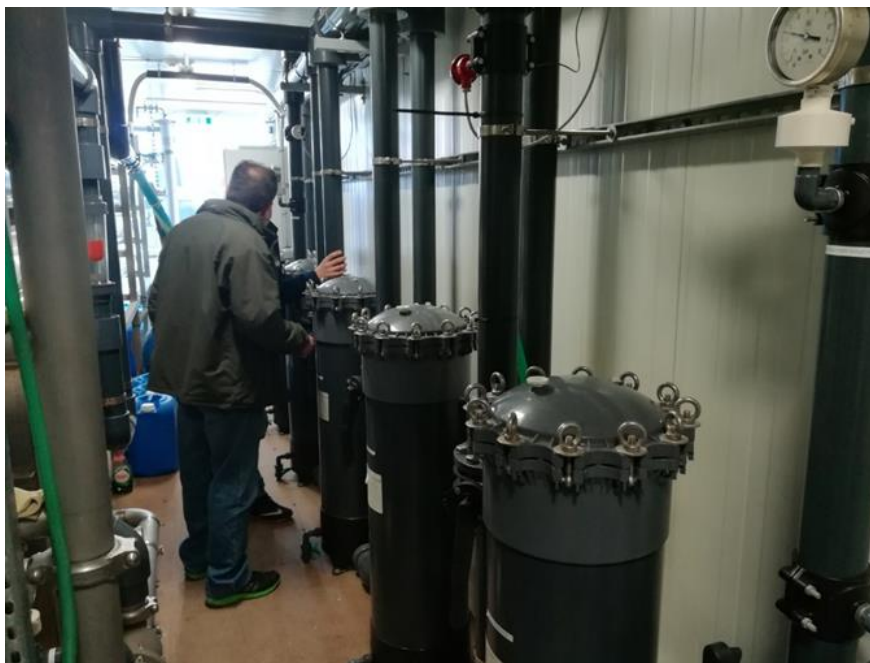
Εικόνα 3.19 Φίλτρα πολλαπλών φυσιγγίων
