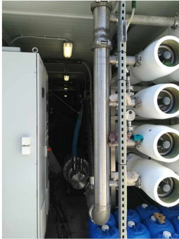
Εικόνα 3.21 Συστοιχία αντίστροφης ώσμωσης
