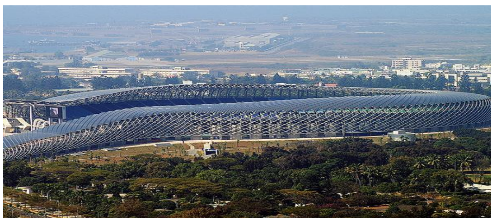
Εικόνα 6: Το Στάδιο Kaohsiung καλύπτεται από Φ/Β στη στέγη του και είναι 100% ηλιακό. Πηγή: www.cladglobal.com
