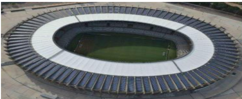
Εικόνα 5: Εγκατάσταση Φ/Β στη στέγη του γηπέδου Maracana, Βραζιλία Πηγή: http://solar energy USA.com/
