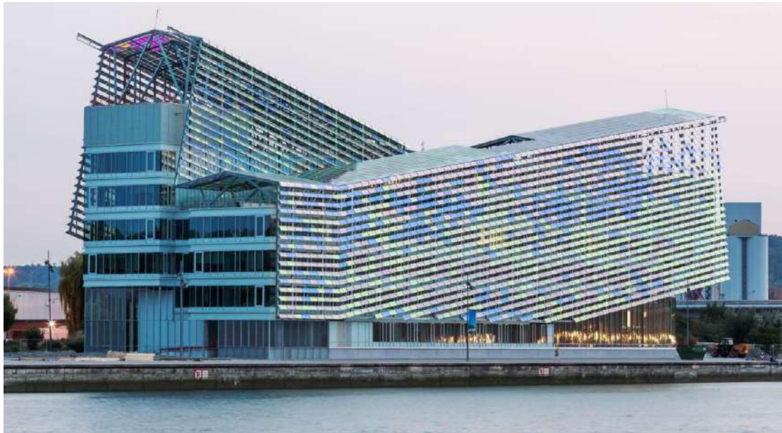
Εικόνα 2.2 Όψη υπηρεσίας τοπικής αυτοδιοίκησης στην πόλη Ρουέν της Γαλλίας [15]
