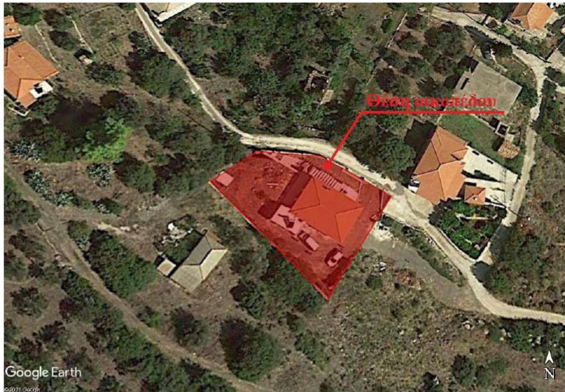
Εικόνα 6.1 Η θέση του οικοπέδου μέσω Google Earth (έτος 2018)
