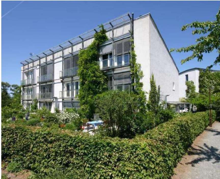
Εικόνα 1.5 Όψη του πρώτου Παθητικού Κτιρίου στον κόσμο (Passivhaus Darmstadt Kranichstein) [5]
