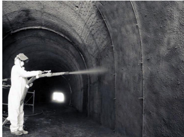
Εικόνα 1.9: Εικόνα: Gunite Μηχανή Εκτόξευσης Σκυροδέματος. Πηγή: http://www.gunitemagnisia.4ty.gr/more2.php?l=el&id=7368&_ga=2.225297817.2048054748.1638815722-2134892687.1638815722
