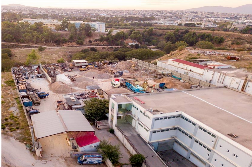
Εικόνα 3.4: Εργοστάσιο/σταθερή μονάδα ανακύκλωσης αποβλήτων εκσκαφών και κατεδαφίσεων. Πηγή: https://kostelidisrecycling.gr/recycling-aekk/
