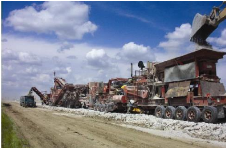
Εικόνα 3.9: Επί τόπου ανακύκλωση οδοστρώματος από Σκυρόδεμα. Πηγή: «Ψυχρή Επιτόπου Ανακύκλωση Οδοστρωμάτων με Τσιμέντο» INTERBETON.
