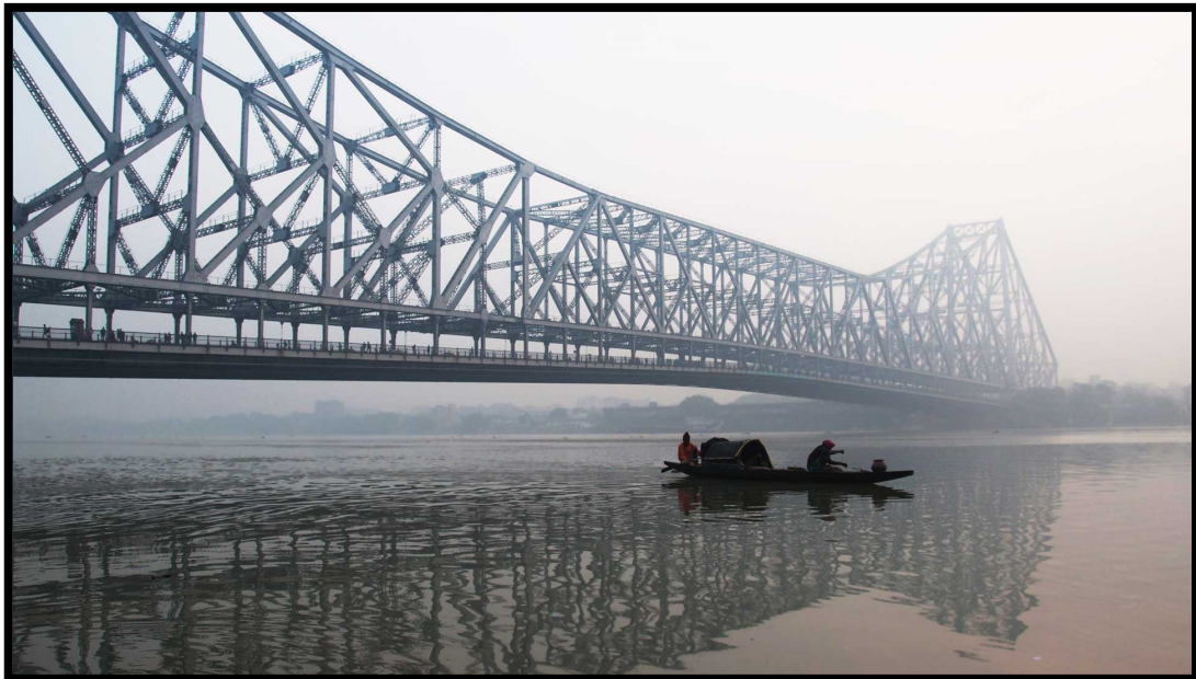
Εικόνα 11. Γέφυρα Howrah - Ινδία
