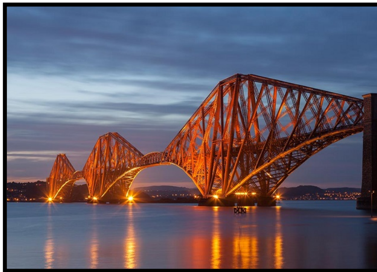
Εικόνα 4. Γέφυρα Forth – Ηνωμένο Βασίλειο
