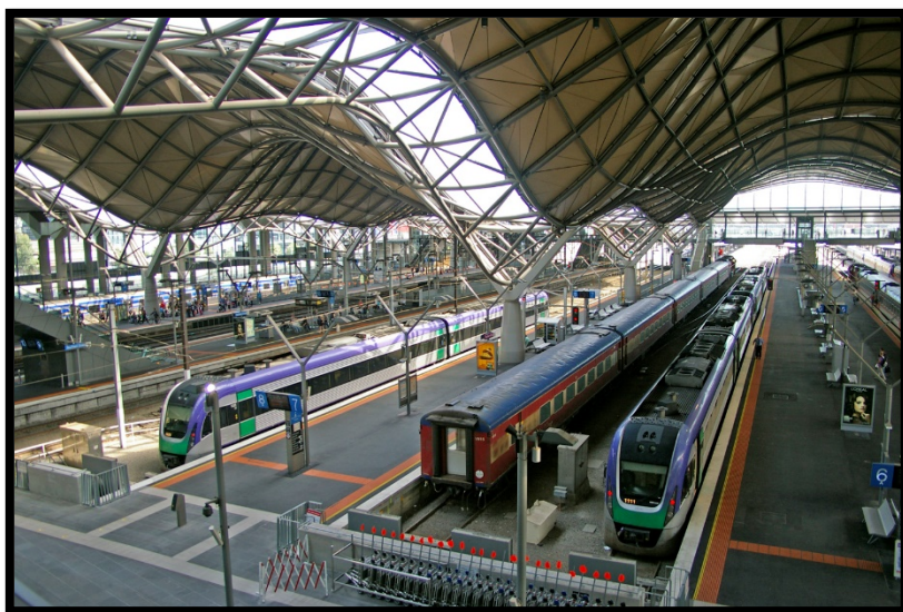
Εικόνα 10. Στέγαση Σιδηροδρομικού Σταθμού - Αυστραλία
