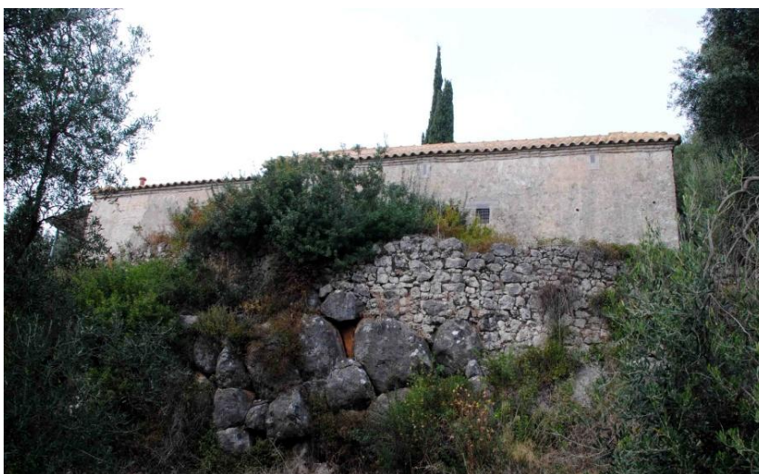
Εικ. 20: Αη Μιχάλης στον Αρίλλα Θεσπρωτίας. Άποψη από Ν. Αναλημματικός τοίχος που εδράζεται επί τμήματος αρχαίου τείχους
