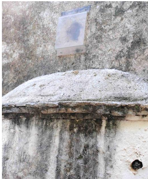
Εικ. 57: Τοποθέτηση διαφανών πετασμάτων εξωτερικά
