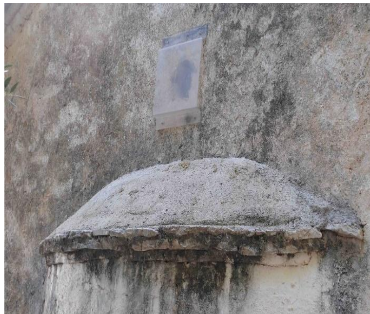
Εικ. 72: Τεταρτοσφαίριο αψίδας και προστατευτικό πέτασμα ανατολικού παραθύρου
