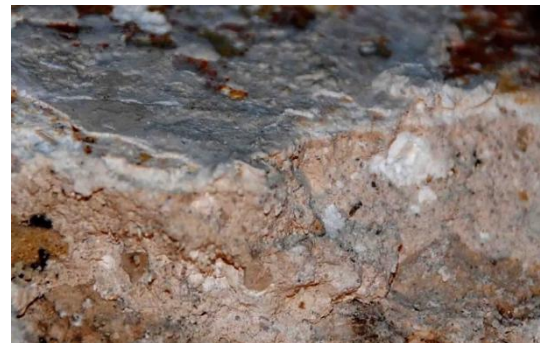
Εικ. 44: Η δομή του κονιάματος εξομάλυνσης
