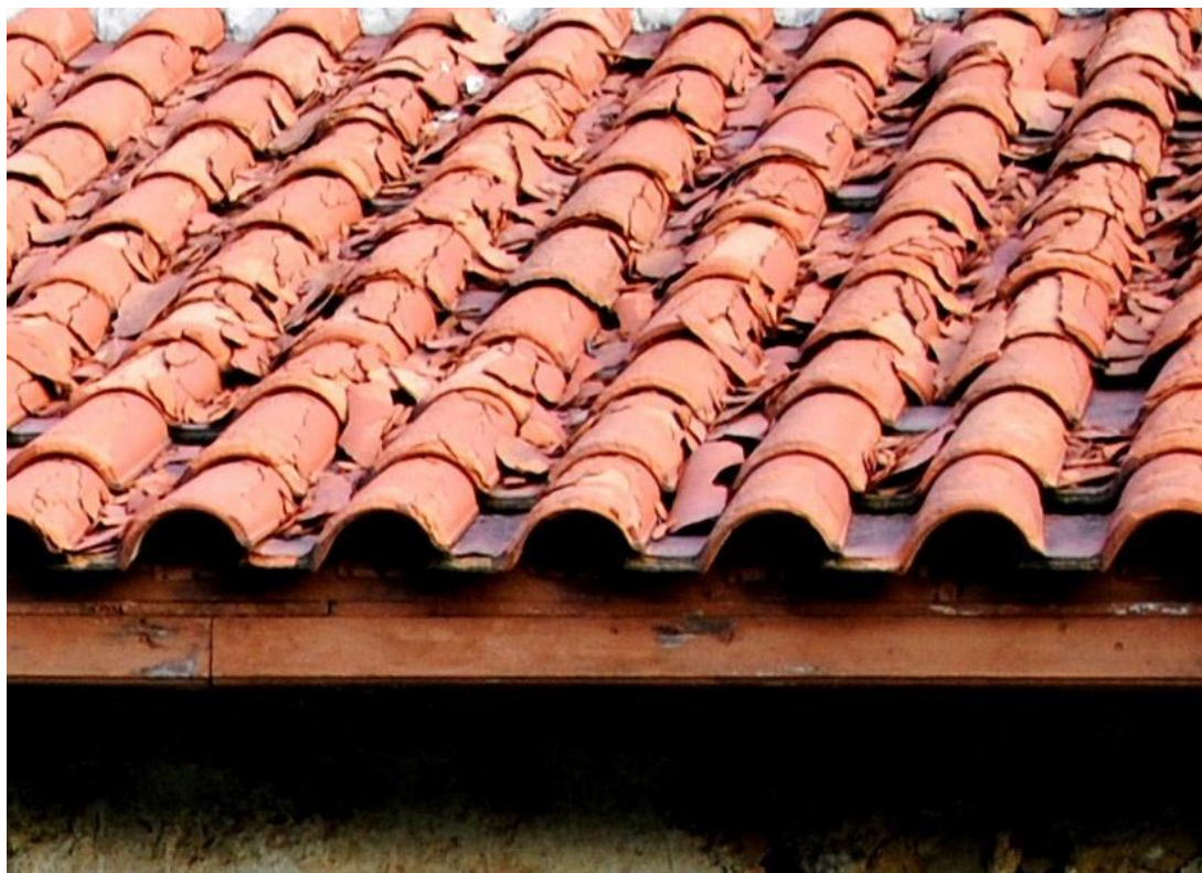
Εικ. 16: Θραύση κεραμιδιών από παγετό (Παπαδοπούλου & Κονιδιτσιώτης, 2016)
