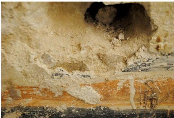
Εικ. 45: Η στρωματογραφία όπως αποκαλύπτεται σε περιοχές απωλειών. Περιοχή με το λεπτόκοκκο στρώμα επιχρίσματος σε ικανό πάχος (10mm)
