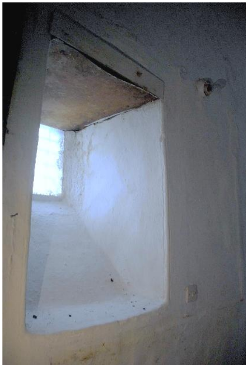
Εικ. 56: Εσωτερική διαμόρφωση παραθύρων
