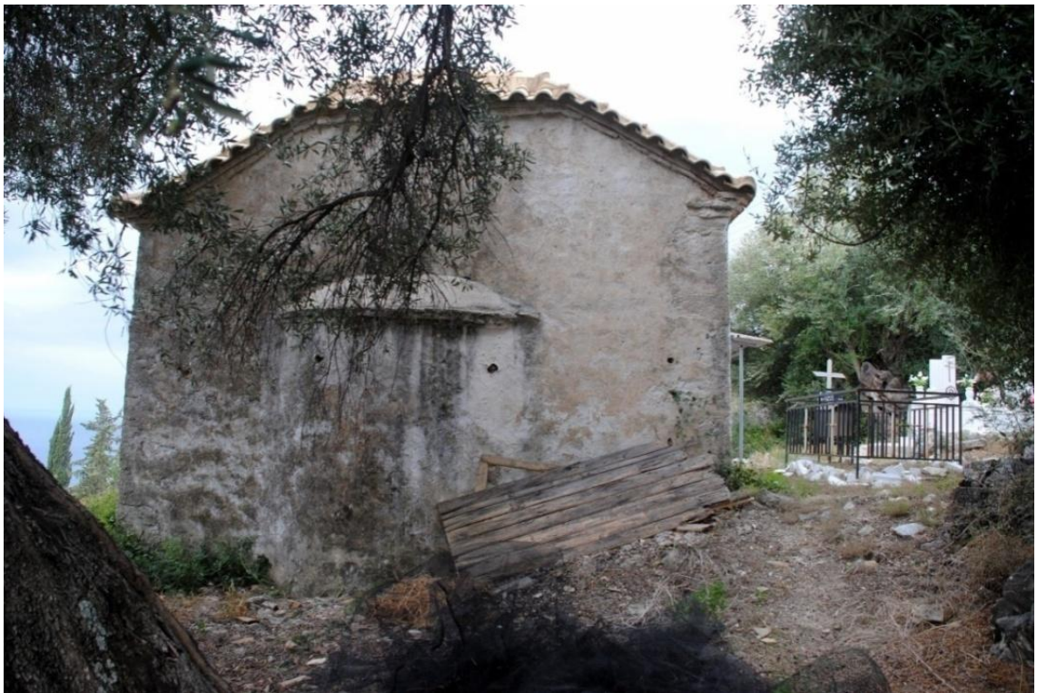
Εικ. 25: Ανατολική όψη: εμφανής η κατωφέρεια, η ημικυκλική αψίδα του ιερού, η λοξή απότμηση στη στέγη και οι οπές της ξυλοδεσιάς
