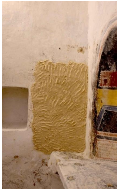
Εικ. 77: Ιερό, βόρειος τοίχος (BA). Η θέση της εφαρμογής επιθέματος
