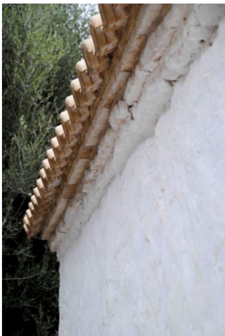
Εικ. 26: Το γείσο στη στέψη της τοικοποιίας
