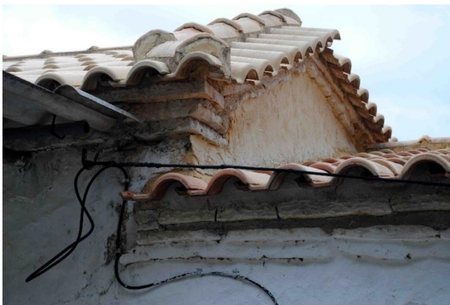
Εικ. 51:Υψομετρική διαφορά μεταξύ δυτικού τοίχου του κυρίως ναού και νεώτερου νάρθηκα
