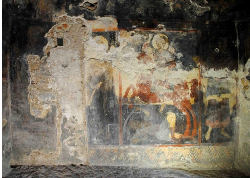
Εικ. 6: Ποικιλία αλλοιώσεων λόγω υγρασίας
