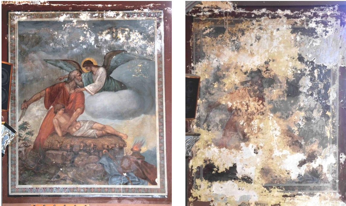
Εικ. 1: Τοιχογραφία αρχών 20 ου αι. Αριστερά, το 2014. Δεξιά, το 2020. Ολοκληρωτική καταστροφή σε έξι μόλις χρόνια υπό την επίδραση της υγρασίας.
