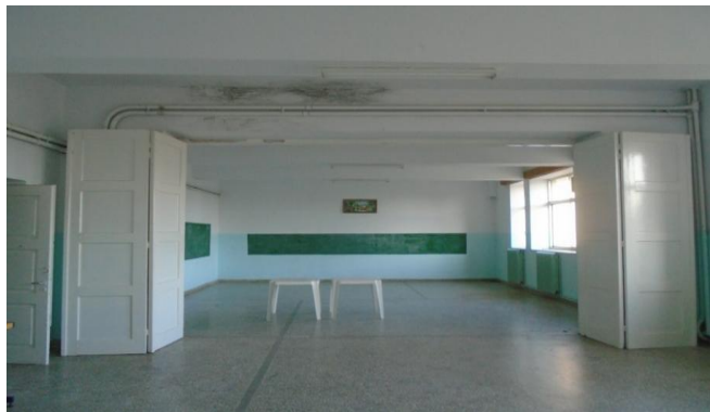
Εσωτερικό άνοιγμα στο ισόγειο για την επικοινωνία των αιθουσών
