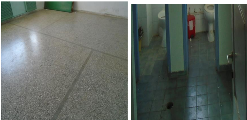
Δάπεδο ισόγειου και ορόφου – WC από πλακίδια
