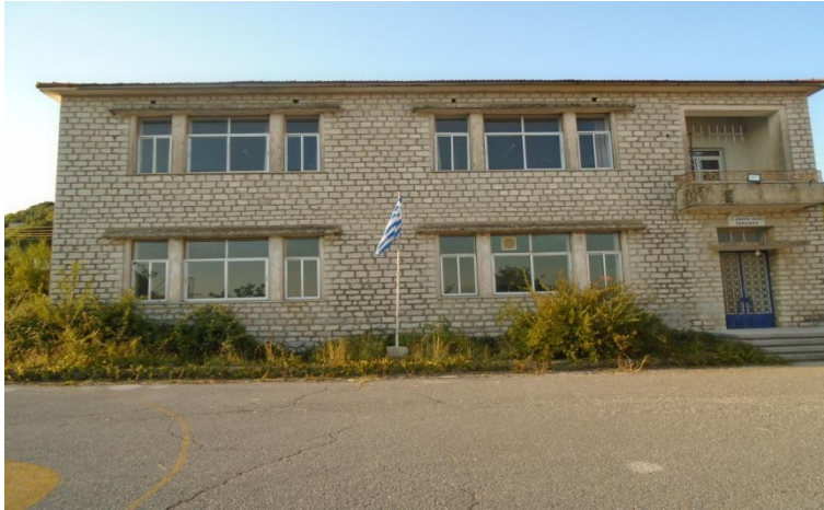
Νότια όψη κτιρίου
