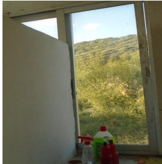
Παράθυρο στο χώρο του WC
