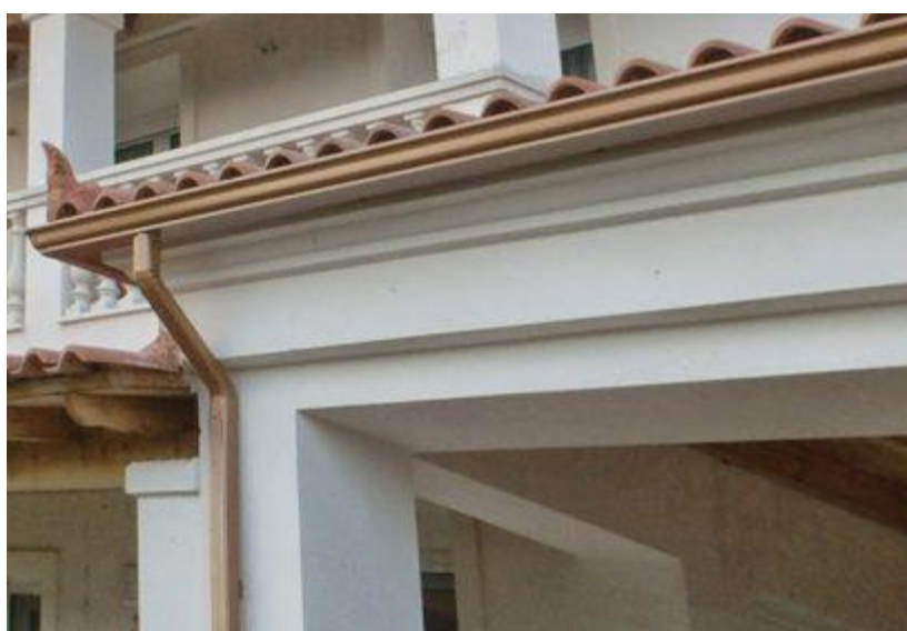
Υδρορροές κάθετες και οριζόντιες
