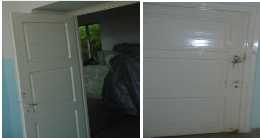
Εσωτερικά ξύλινα ανοίγματα
