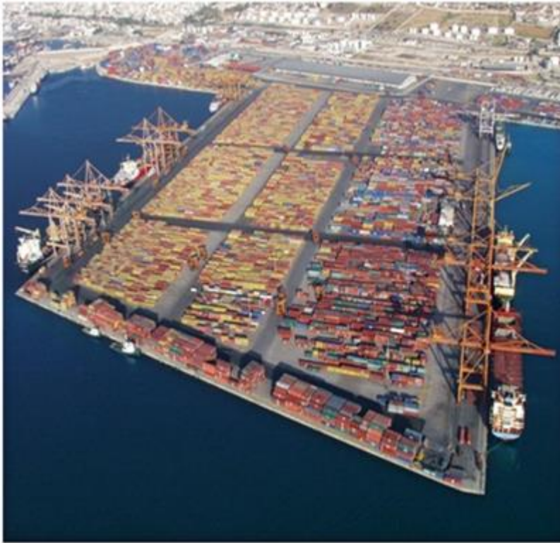
Εικόνα 5-2.2: Ο σταθμός ΣΕΜΠΟ
