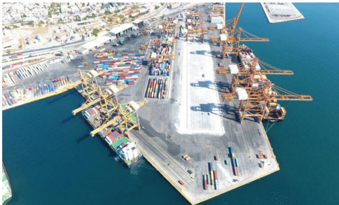
Εικόνα 5-2.1: Ο σταθμός ΣΕΜΠΟ
