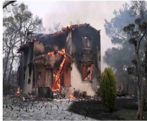
Εικόνα 3: Κατεστραμμένο σπίτι από την πυρκαγιά στην Βαρυμπόμπη 2021. Πηγή: Αρχείο Ερυθρού Σταυρού.
