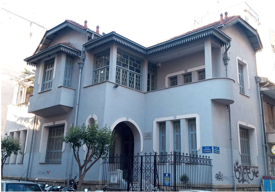
Εικόνα 35 : Κτίριο Μακρή επί της οδού Γαριβάλδη και Βύρωνος γωνία , πηγή : Δάσου Άννα, Απρίλιος 2022
