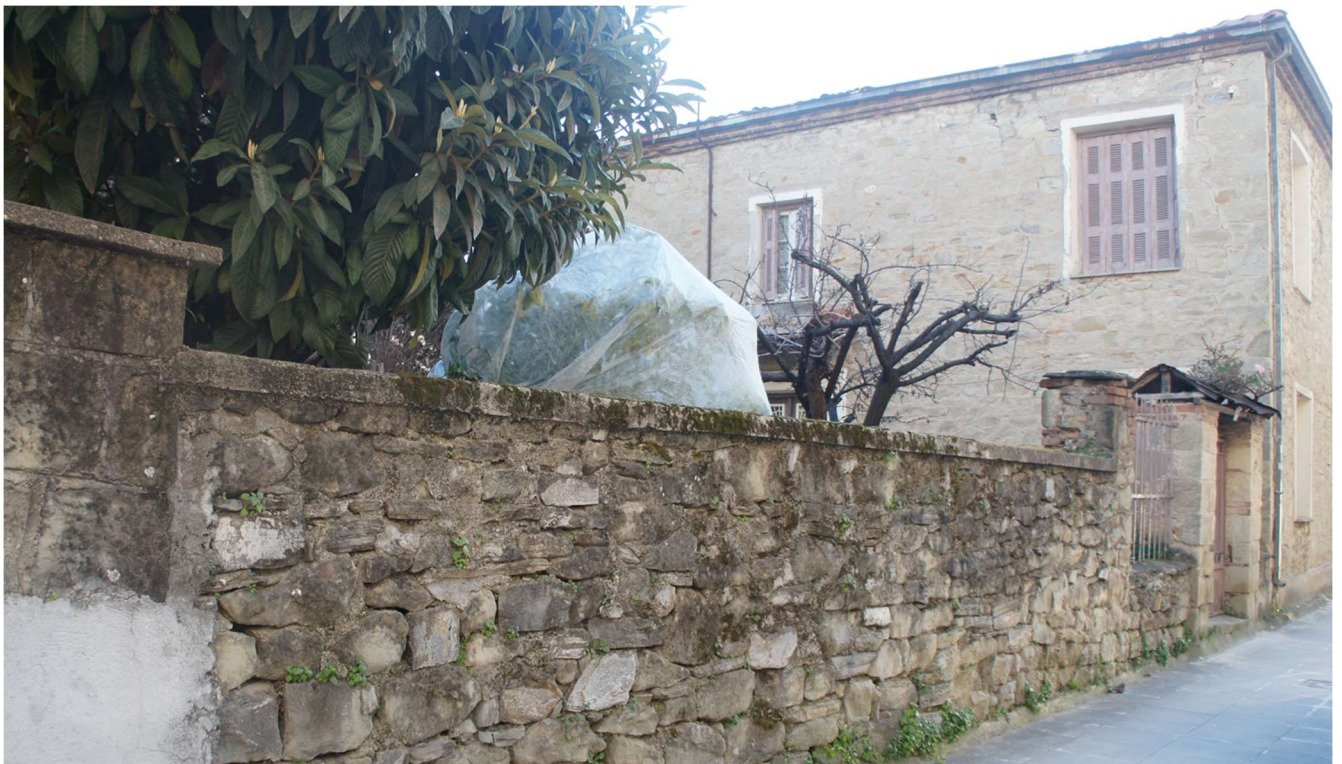
Εικόνα 23 :Γειτνιάζουσες κατοικίες επί της οδός Θεμιστοκλέους , πηγή : Δάσου Άννα, Μάρτιος 2022
