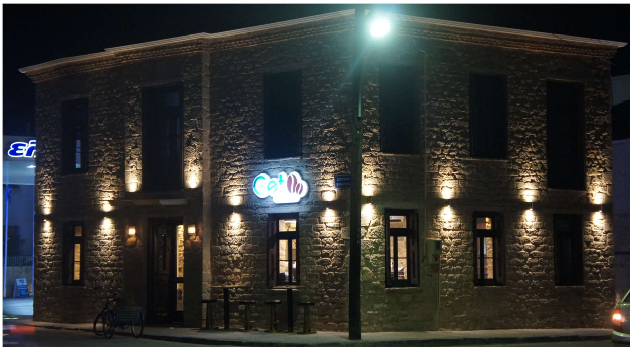
Εικόνα 26 : Επαγγελματική χρήση κτιρίου επί την συμβολή των οδών Συγγρού και Φλεγίου, πηγή : Δάσου Άννα, Μάρτιος 2022
