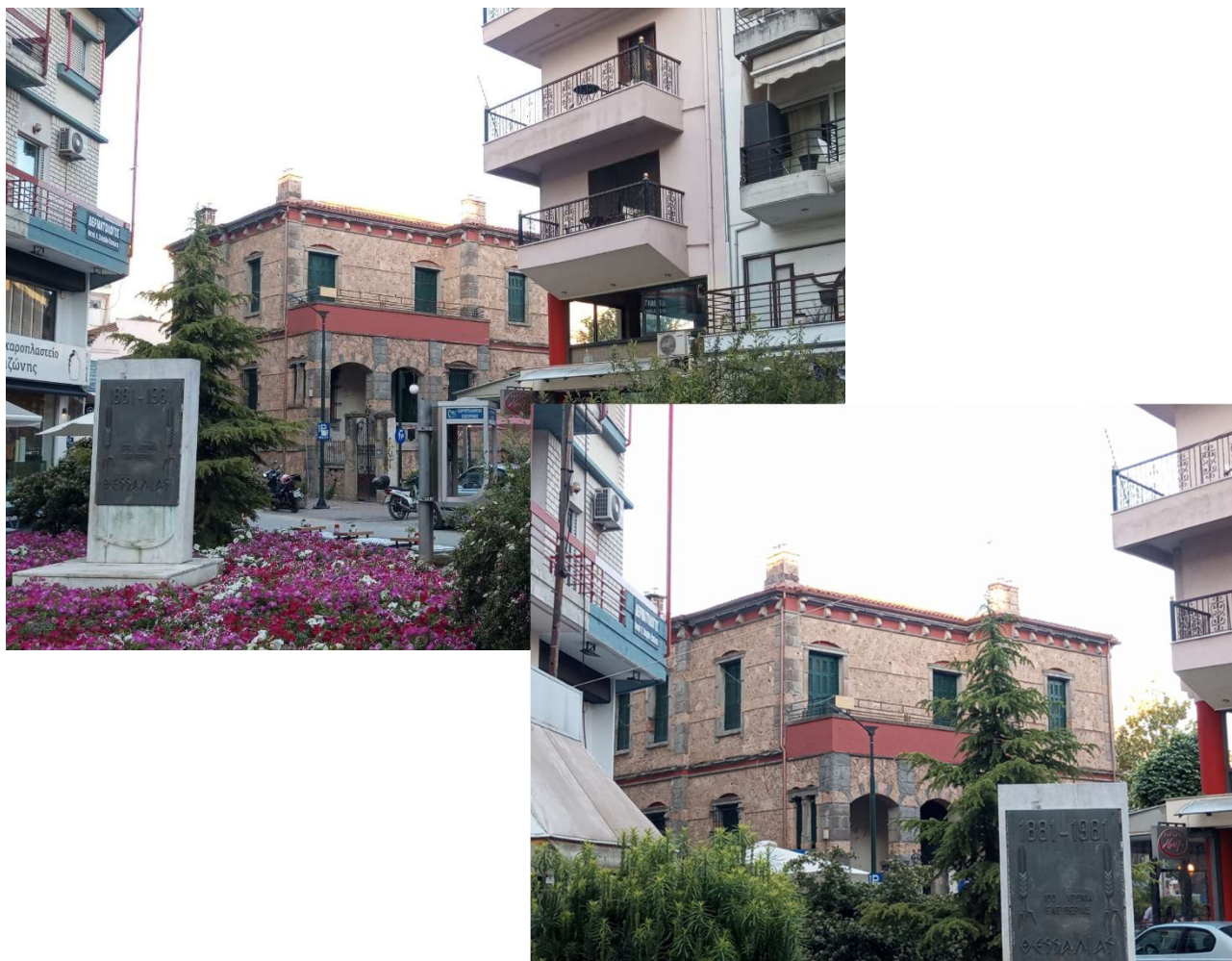
Εικόνα 40 : Άποψη του κτιρίου από την οδό Ασκληπιού, πηγή : Δάσου Άννα , Μάιος 2022
