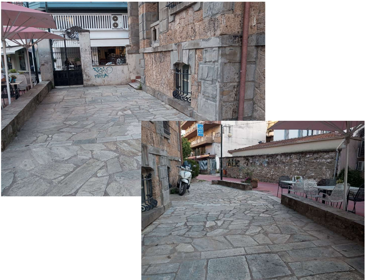
Εικόνα 42: Άποψη του αύλειου χώρου, πηγή: ίδια επεξεργασία, Απρίλιος 2022
