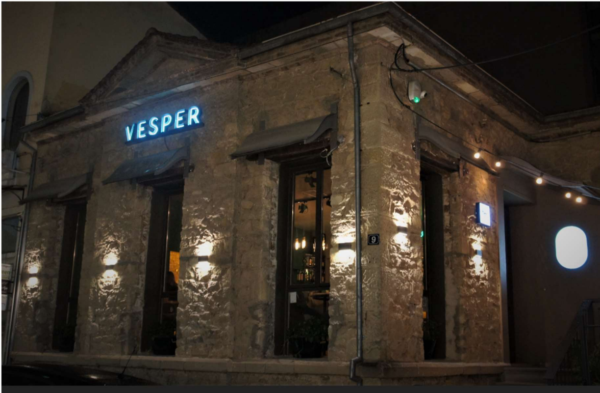
Εικόνα 27 : Επαγγελματική χρήση κτιρίου επί της οδού Καρανάσιου, πηγή : Δάσου Άννα, Μάρτιος 2022
