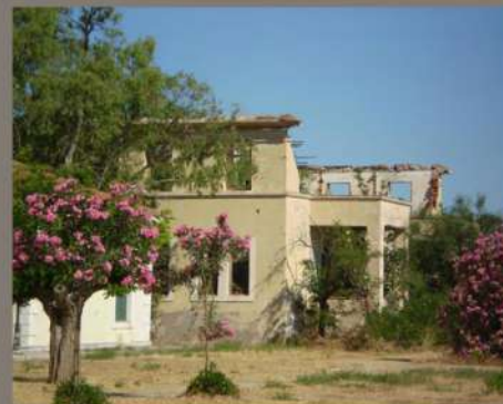
Εικόνα 22: υφιστάμενη κατάσταση κτιρίου 1
