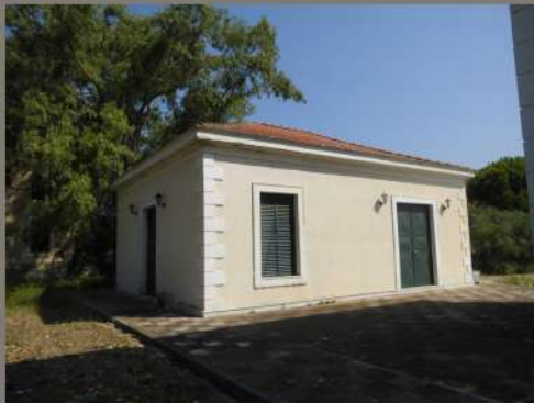
Εικόνα 24: υφιστάμενη κατάσταση κτιρίου 2
