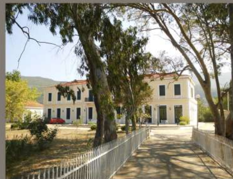
Εικόνα 26: υφιστάμενη κατάσταση κτιρίου 3
