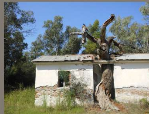
Εικόνα 32: υφιστάμενη κατάσταση κτιρίου 6
