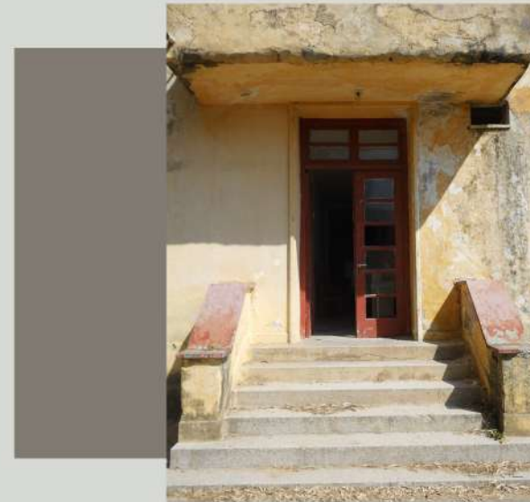
Εικόνα 31: υφιστάμενη κατάσταση κτιρίου 6
