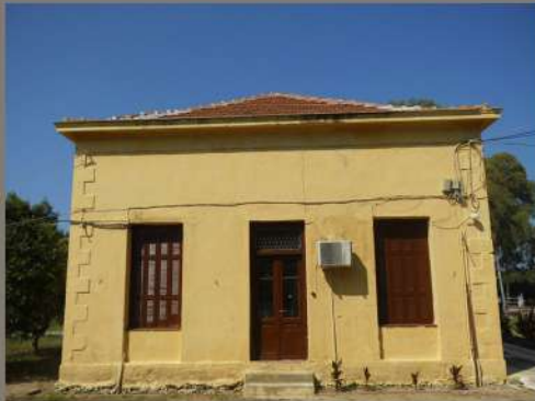
Εικόνα 28: υφιστάμενη κατάσταση κτιρίου 4
