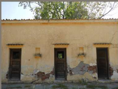
Εικόνα 36: υφιστάμενη κατάσταση κτιρίου 9
