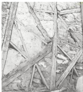
Εικόνα 20 : Εσωτερικός τοίχος από ξύλα και άργιλο στην Σύρο, πηγή : (Κάρτας, 1982, σ. 24)
