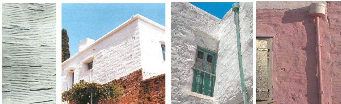
Εικόνα 28 : Αριστερή : σαρδέλωμα με πέτρες, μεσαίες : σαρδέλωμα με πέτρες στην Άνδρο και στην Σύρο, πηγή : (Λυγίζος, Παλιά Αντριάτικα Σπίτια, 1983, σσ. 251,252), δεξιά : απλό σαρδέλωμα με χρώμα στην Σύρο, πηγή: (Κάρτας, 1982, σσ. 33,39)
