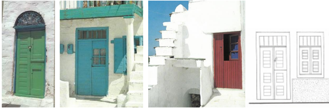
Εικόνα 44 : Αριστερά : ξύλινη θύρα στη Σύρο με το ένα φύλλο κομμένο στα δύο για ηλιασμό, (Κάρτας, 1982, σ. 33) , μεσαία : θύρες στην Τήνο όπου το πάνω φύλλο αποτελείται από τζάμι για ακόμα περισσότερο φως και δεξιά : σκίτσο κουφωμάτων όψης (Σύρος), πηγή : (Φιλιππίδης, 1982, σσ. 279,295)
