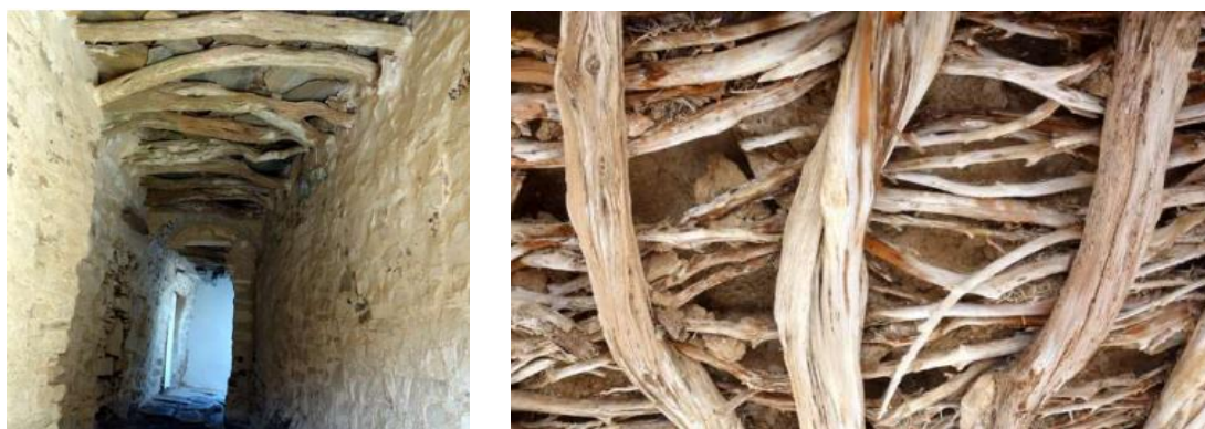
Εικόνα 57 : Στεγάδι στην Σίκινο και εσωτερική όψη στεγαδιού στην Κίμωλο, πηγή : (Αγναντοπούλου, 2020, σσ. 166,176)
