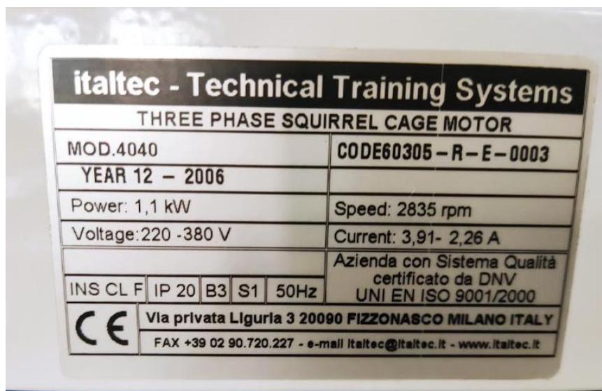
44 Εικόνα 5.1: Ονομαστική πινακίδα κινητήρα.
