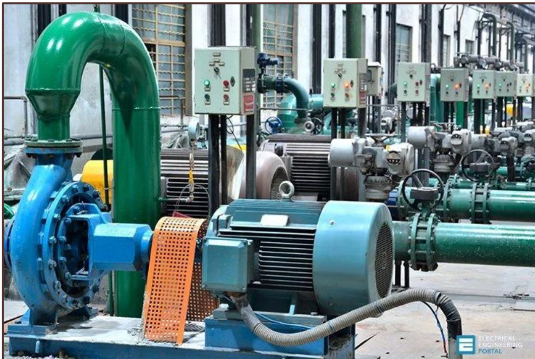
41 Εικόνα 4.17: Οι τριφασικοί επαγωγικοί κινητήρες βρίσκουν πολλές εφαρμογές στη βιομηχανία (Jape, S. & Thosar, A., 2017).
