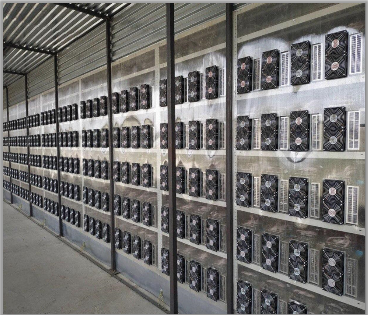
Εικόνα 15: Κτίριο Στέγασης Mining Pool Εταιρίας Πηγή: Coindesk
