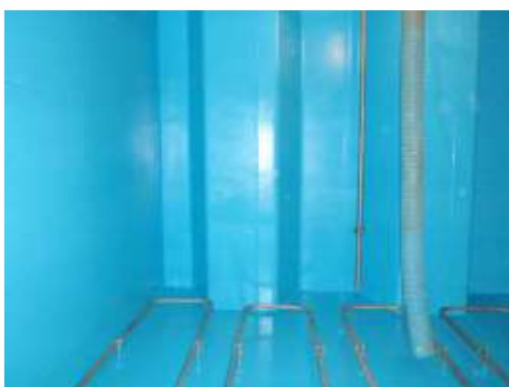
Εικόνα 28. Πυθμένας δεξαμενής φορτίου με τελική στρώση βαφής. Πηγή: Chemco Int.
