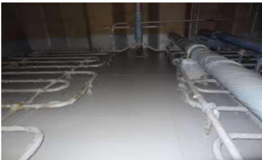
Εικόνα 27. Πυθμένας δεξαμενής όπου έχει εφαρμοστεί το τελικό χρώμα.
