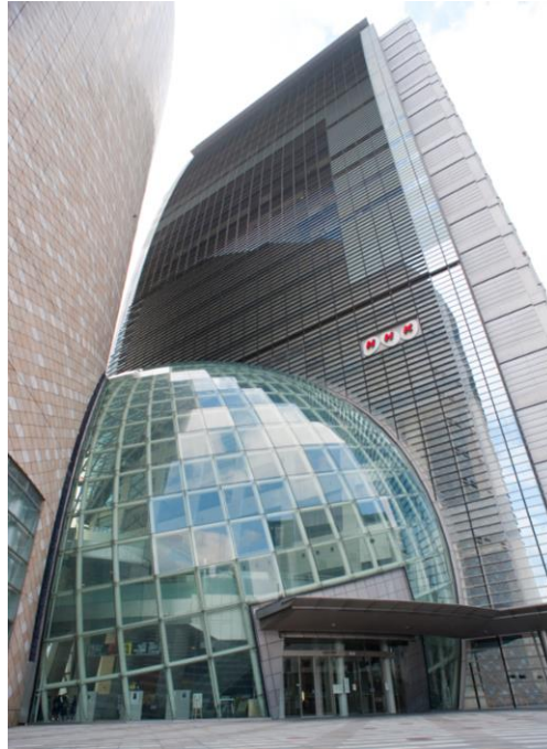
Εικ. 31: Ο ραδιοφωνικός σταθμός NHK που χτίστηκε στον ιστορικό χώρο. Πηγή: © Ελεύθερη Χρήση, https://photoeverywhere.co.uk/east/japan/osaka/slides/nhk_osaka.htm
