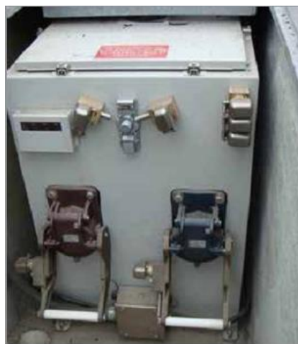
Εικόνα 3.5: Υποδοχή εγκατάσταση καλωδίων τροφοδοσίας.
