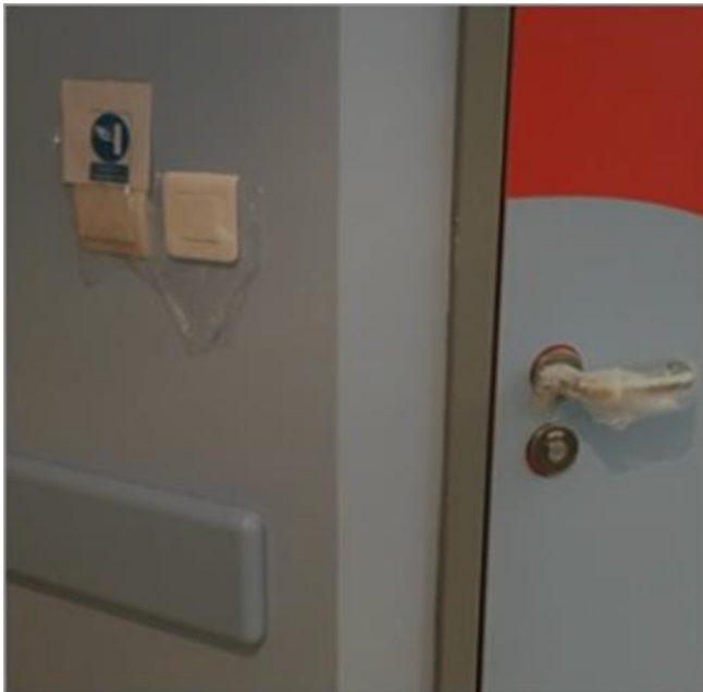
Εικόνα 15 Καλυμμένοι διακόπτες και χερούλια για αποφυγή ραδιομόλυνσης (Πτυχιακή εργασία με τίτλο «Συμβολή της Πυρηνικής Ιατρικής σε Παιδιατρικούς ασθενείς» της Διαμαντοπούλου Αικατερίνης)
