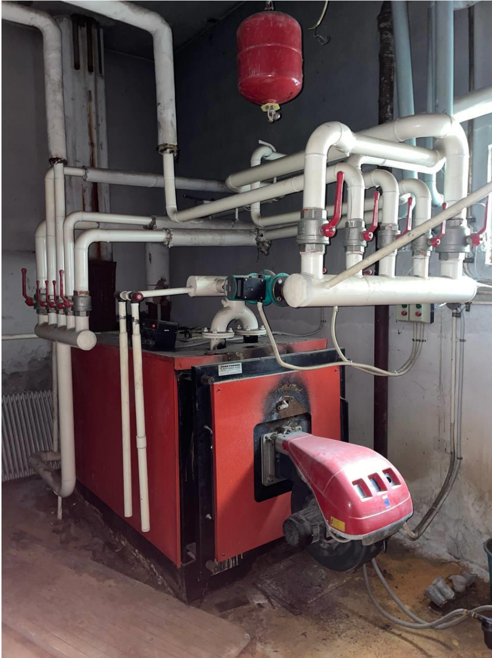
Εικόνα 23: Χαλύβδινος Λέβητας μεγάλου μεγέθους
