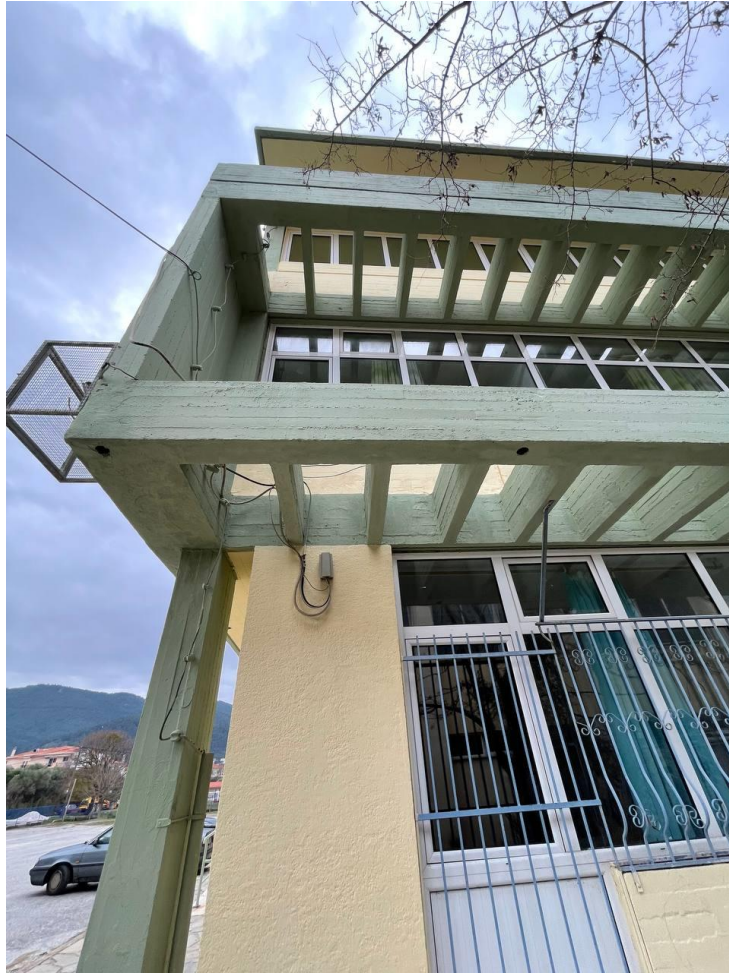
Εικόνα 35: Όψη με λεπτομέρειες προβόλων
