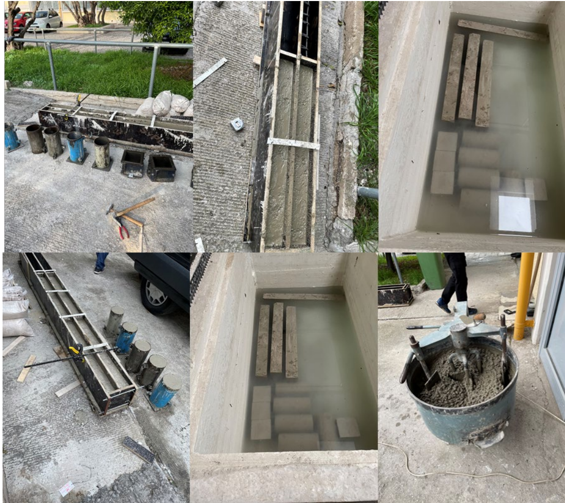
Εικόνα 14. Ανάμιξη μείγματος σκυροδέματος σε ηλεκτρική μπετονιέρα, διάστρωση και συντήρηση δοκιμίων στο νερό
