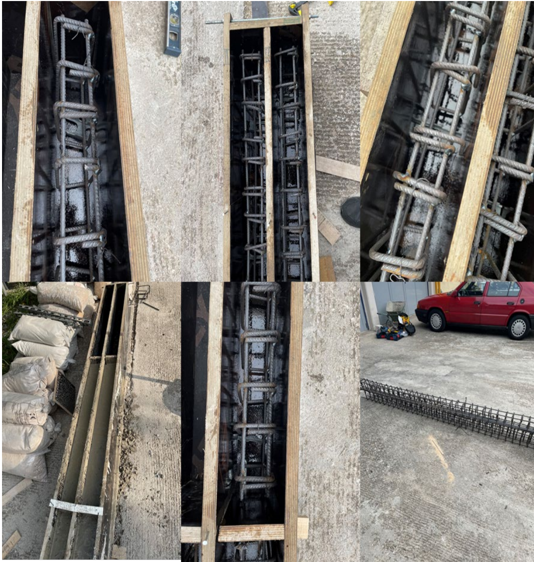
Εικόνα 13. Ξυλότυπος γραμμικού δοκιμίου και οπλισμός.
