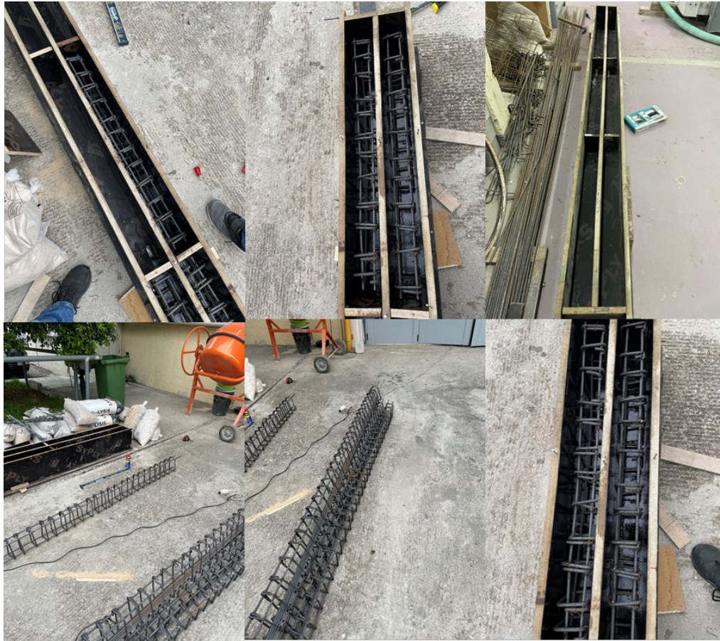
Εικόνα 12. Ξυλότυπος γραμμικού δοκιμίου και οπλισμός
