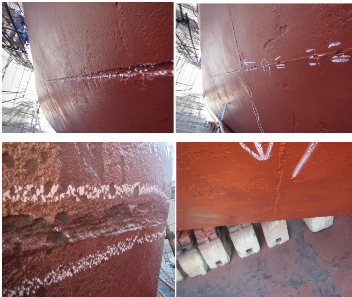
Εικόνα 39: Εμφανείς φθορές στην μεταλλική κατασκευή ενός πλοίου που λειτουργούσε 2 χρόνια χωρίς καθοδική προστασία. Η ζημιά στις κολλήσεις είναι εμφανής (προσωπικό αρχείο)
