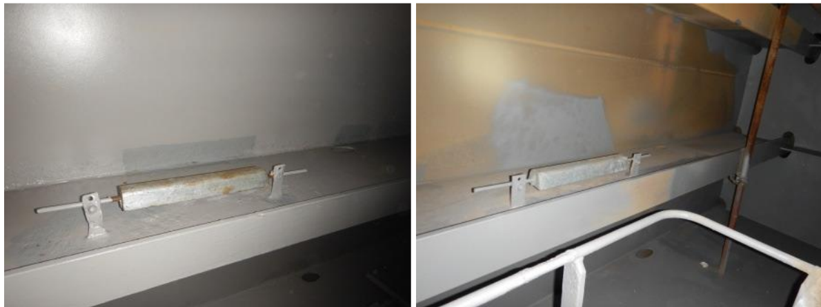
Εικόνα 30: Αλλαγή ανοδίων σε Water Ballast Tanks πριν(αριστερά) και μετά(δεξιά) (Report of S.S V)
