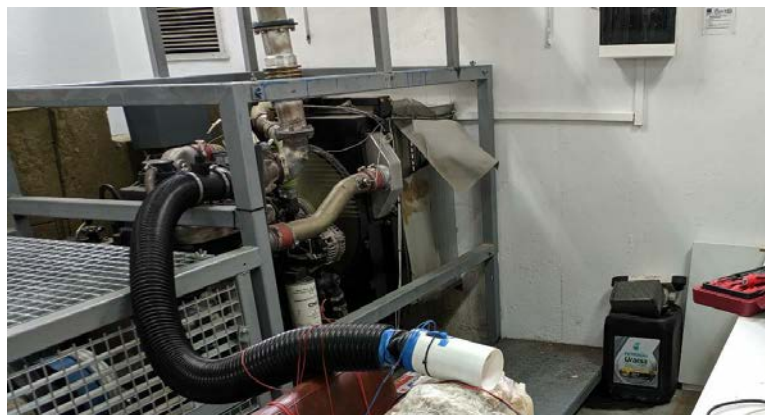
Εικόνα 56: Σύνδεση της νέας αισθητήριας διάταξης με τον σωλήνα εισαγωγής της μηχανής
