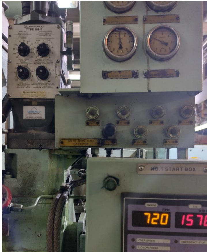
Σχήμα 7-4 Αυτόματος ρυθμιστής στροφών UG - 8 τοποθετημένος σε πετρελαιοκινητήρα (πάνω αριστερά). Κάτω δεξιά είναι η ταχύτητα περιστροφής του κινητήρα (720 rpm).
