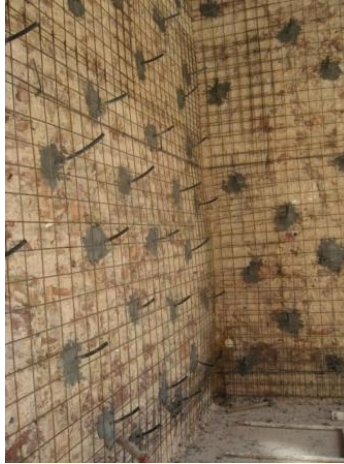
ΦΩΤΟΓΡΑΦΙΑ 2 : ΕΠΙΣΚΕΥΗ ΜΕ ΤΣΙΜΕΝΤΕΝΕΣΕΙΣ
