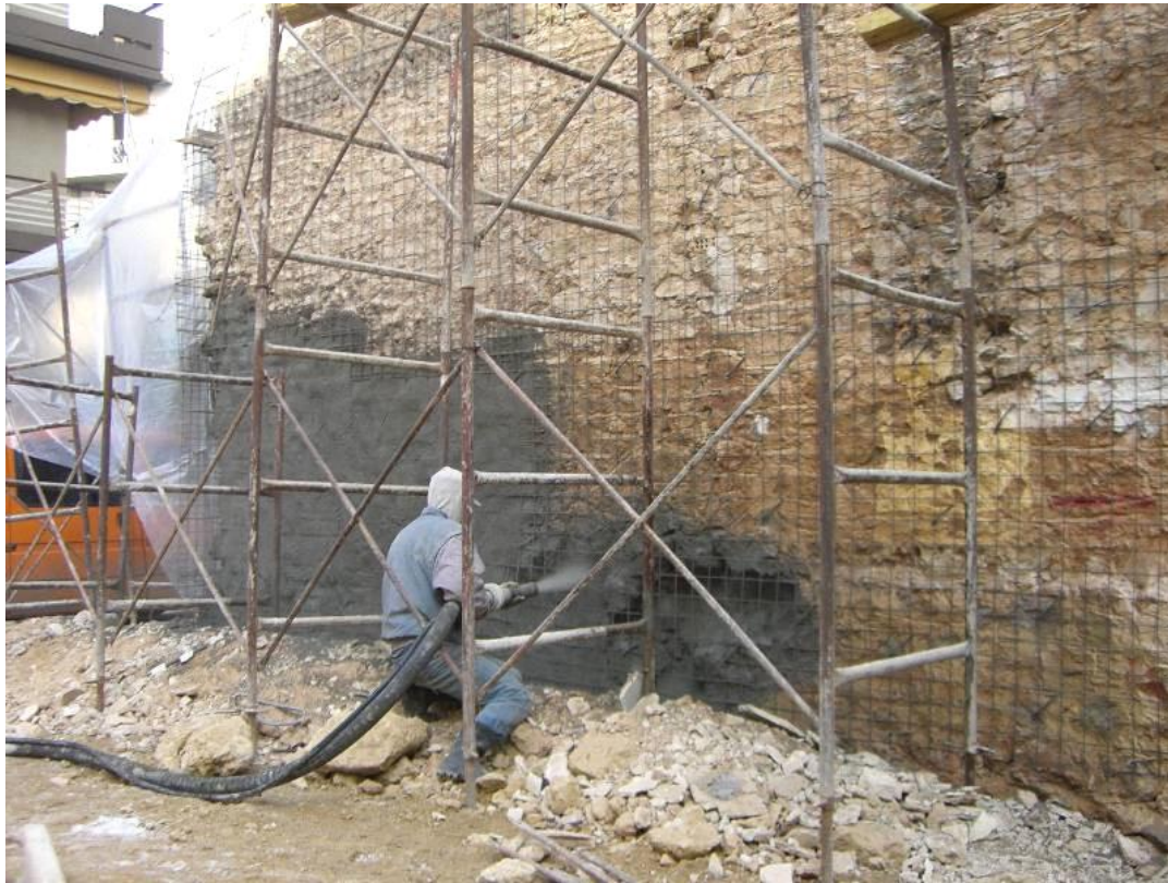
ΦΩΤΟΓΡΑΦΙΑ 1 :ΠΑΡΑΔΕΙΓΜΑ ΕΠΙΣΚΕΥΗΣ ΜΕ ΕΚΤΟΞΕΥΟΜΕΝΟ ΣΚΥΡΟΔΕΜΑ
