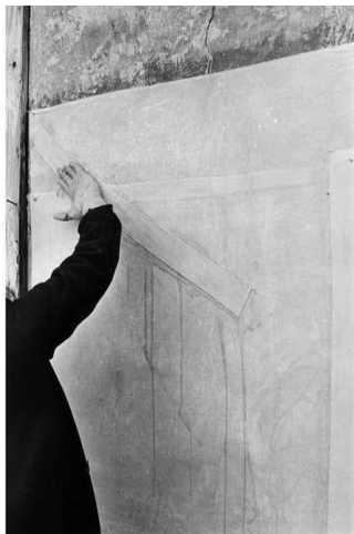
Εικόνα 2.16: «Στύλπωνος 7» (Επεισόδια στην Ύλη), 1979, επικόλληση γάζας στον τοίχο
