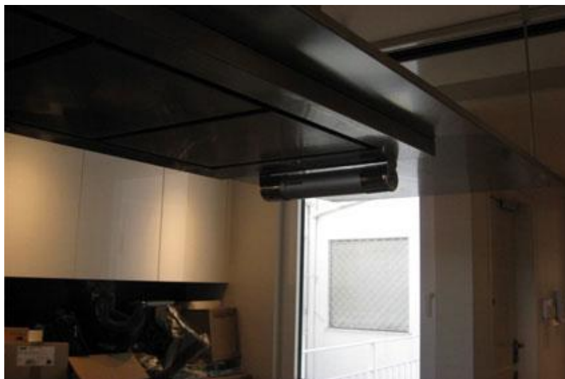
Εικόνα 10:Σύστημα πυρόσβεσης BONPET σε χώρο της κουζίνας(www.gds.com.gr,άλλες κατοικίες)
