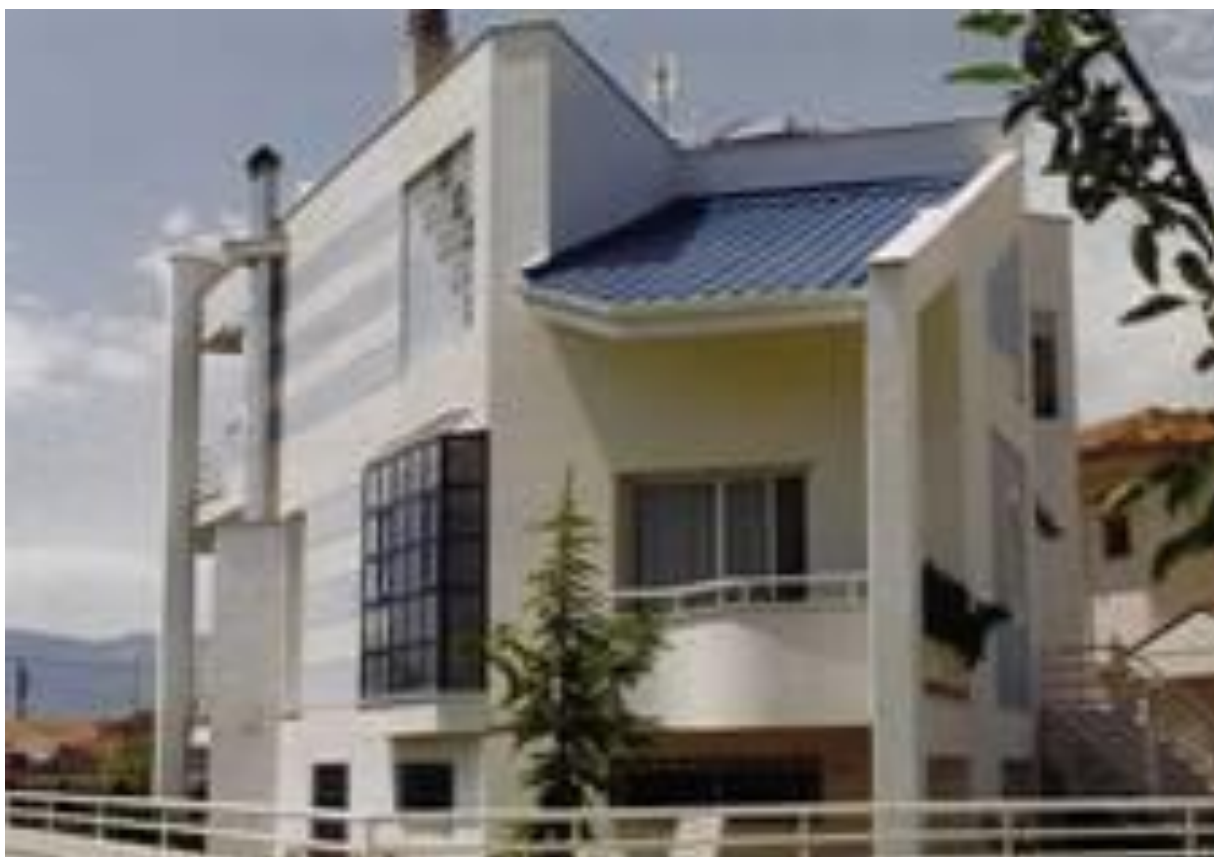
Εικόνα 26:ΚΑΠΕ - Κέντρο Ανανεώσιμων Πηγών Ενέργειας, Παθητικά Ηλιακά Συστήματα Θέρμανσης
