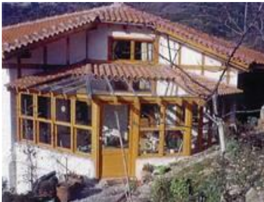
Εικόνα 27: ΚΑΠΕ - Κέντρο Ανανεώσιμων Πηγών Ενέργειας, Παθητικά Ηλιακά Συστήματα Θέρμανσης
