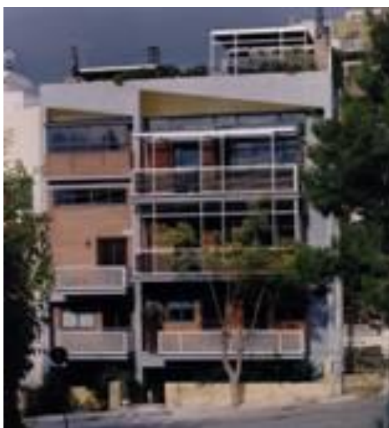
Εικόνα 28: ΚΑΠΕ - Κέντρο Ανανεώσιμων Πηγών Ενέργειας, Παθητικά Ηλιακά Συστήματα Θέρμανσης
