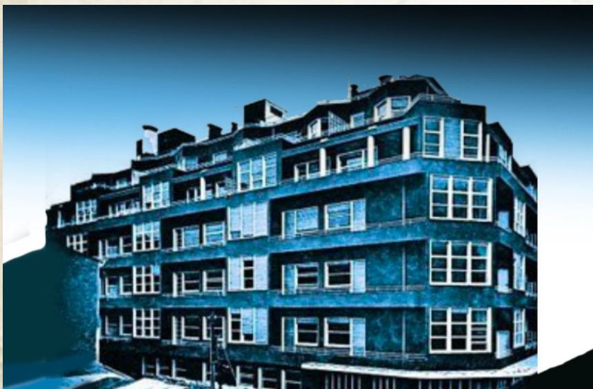
Εικ. 5: Η Μπλε Πολυκατοικία στη συμβολή των οδών Αραχώβης και Θεμιστοκλέους, στην πλατεία Εξαρχείων
