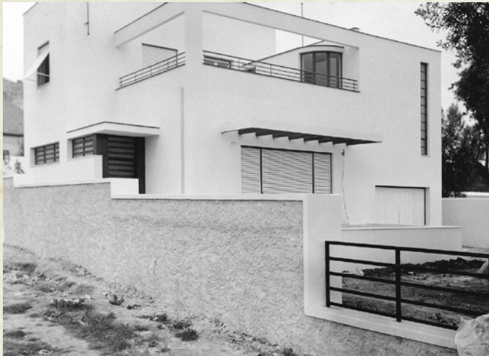
Εικ. 3: Οικία (με εργαστήριο ζωγραφικής) Αδαμάντιου Καλογερόπουλου Πάρνηθος 35, Ψυχικό - αρχιτέκτονας Εμμανουήλ Βουρέκας - 1933
