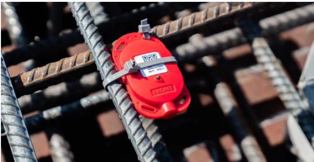
Εικόνα 3-18: Ειδικοί αισθητήρες παρακολούθησης του σκυροδέματος [40]
