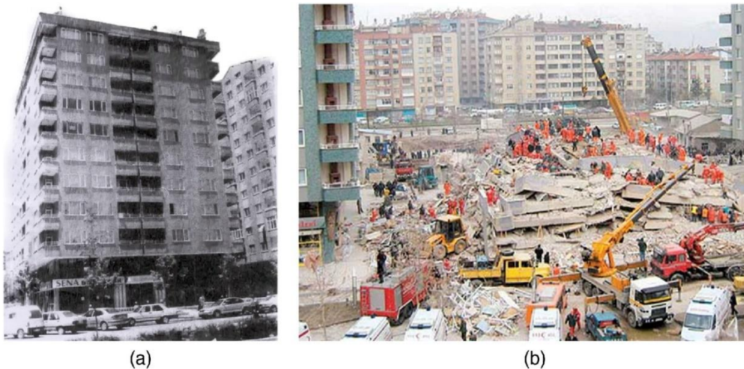
Εικόνα 2-15: Κατάρρευση πολυκατοικίας στο Zuirmut της Τουρκίας εξαιτίας των κατακόρυφων φορτίων [9]
