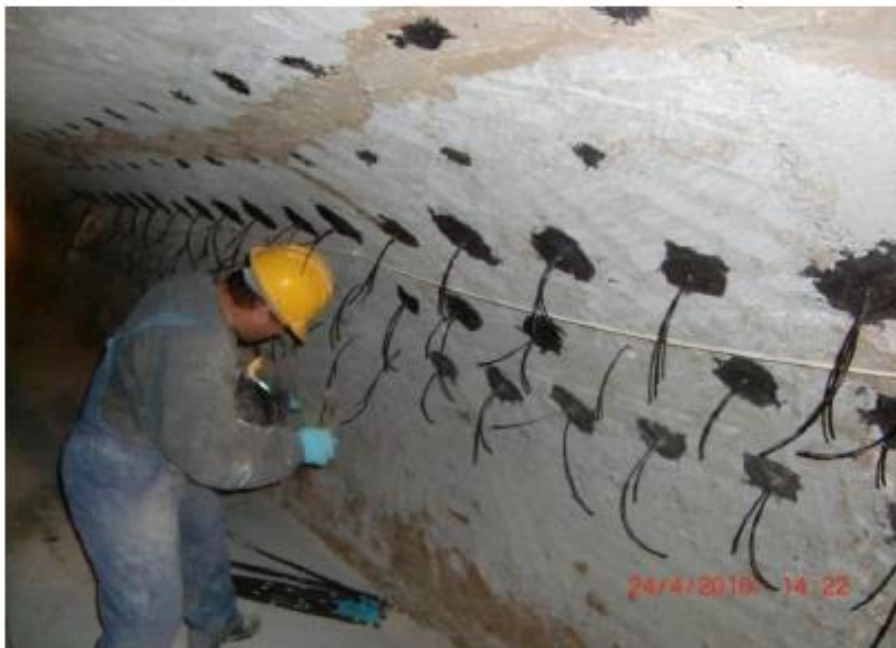
Εικόνα 3-24: Τοποθέτηση βλήτρων [33]
