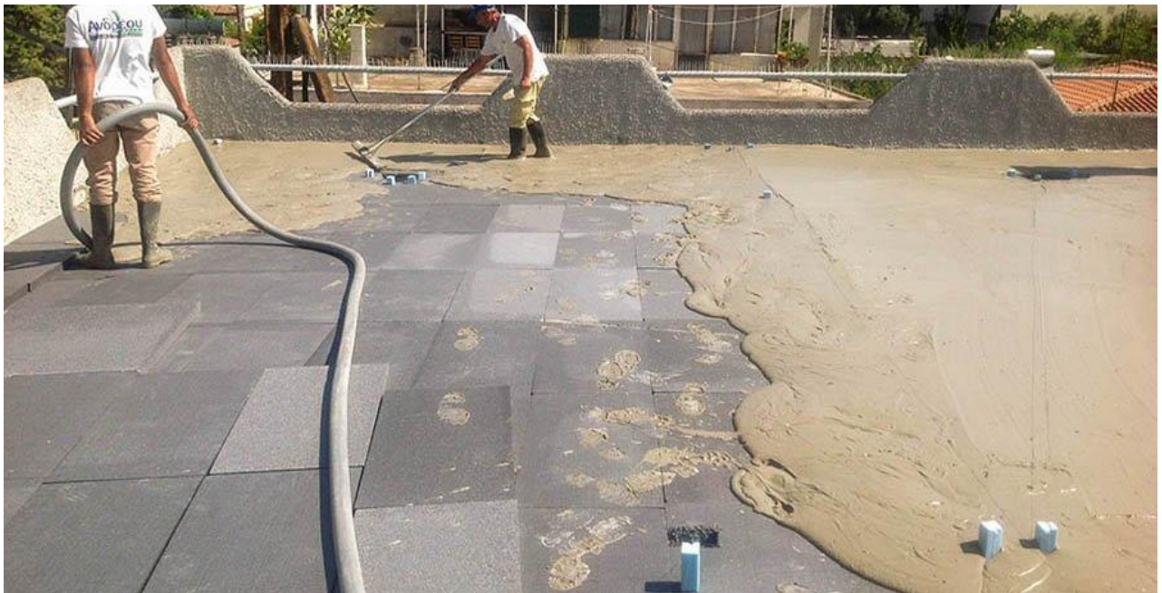
Εικόνα 3-14: Χρήση ελαφροσκυροδέματος σε επίπεδο στέγης για θερμομόνωση
