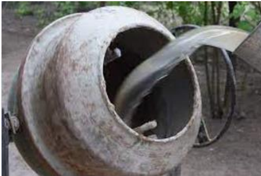
Εικόνα 3-9: Προσθήκη νερού σε μπετονιέρα
