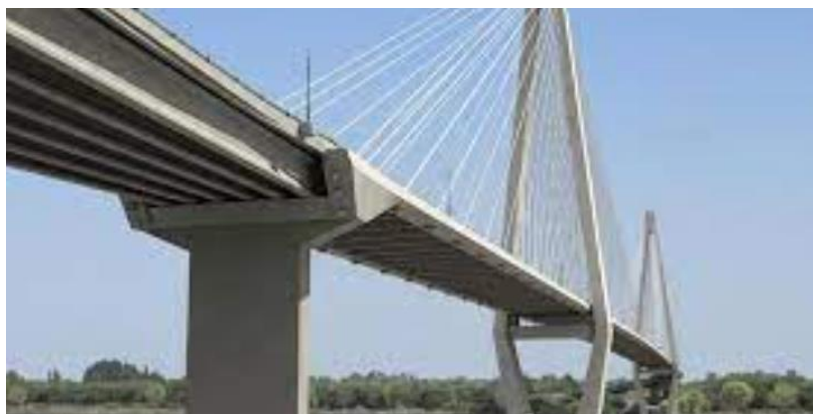
Εικόνα 3-11: Πυλώνες γέφυρας οι οποίοι τυπικά κατασκευάζονται με σκυρόδεμα υψηλής αντοχής
