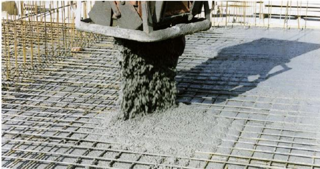
Εικόνα 3-1: Σκυροδέτηση πλάκας σε εργοτάξιο
