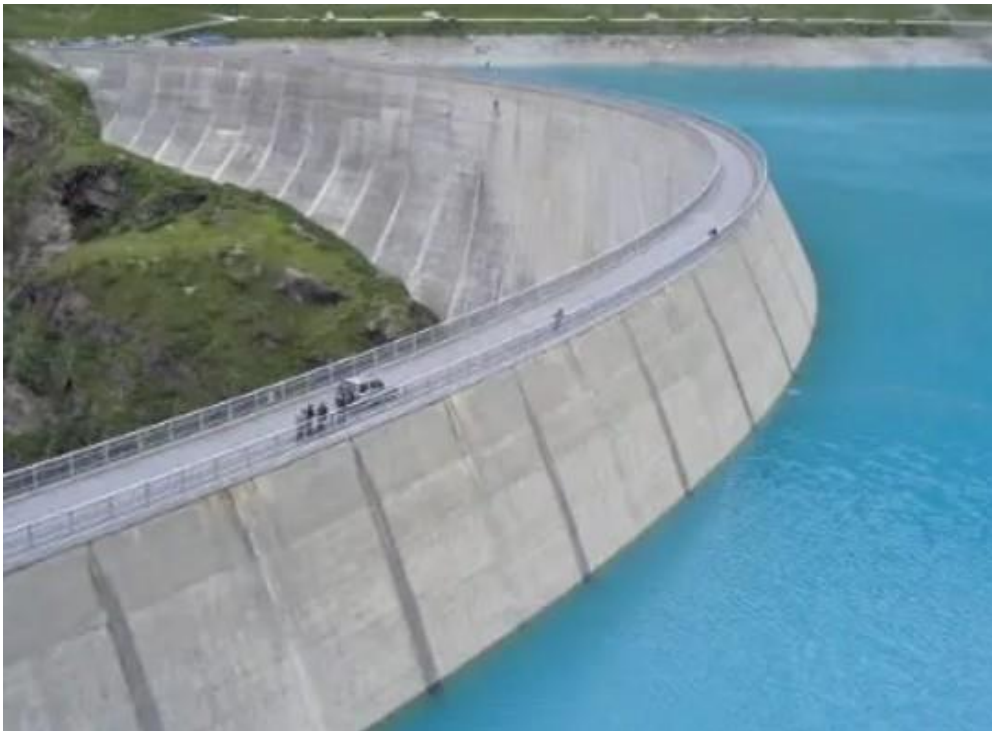
Εικόνα 3-17: Τοξωτό φράγμα σκυροδέματος
