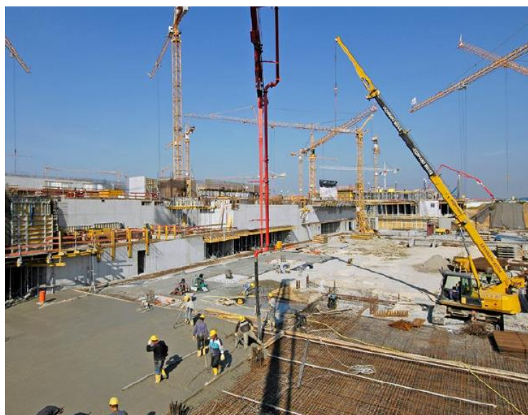
Εικόνα 3-2: Εργασίες σκυροδέτησης σε εργοτάξιο μεγάλης κλίμακας κατασκευής σκυροδέματος
