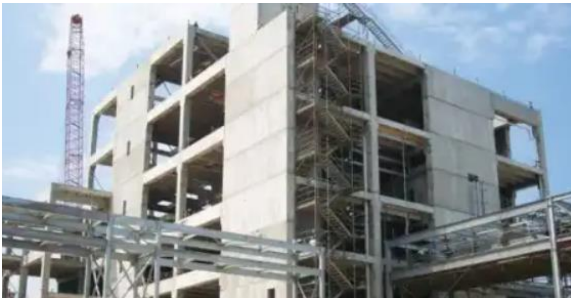
Εικόνα 2-33: Τοιχώματα από οπλισμένο σκυρόδεμα και στις δύο διευθύνσεις σε οικοδομή υπό ανέγερση
