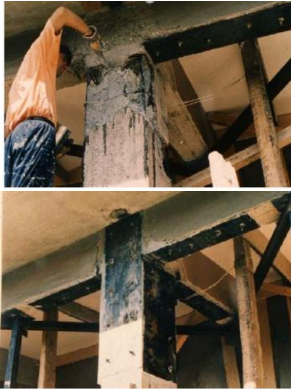
Εικόνα 3-22: Εργασίες επικόλλησης χαλύβδινων ελασμάτων σε δομικά στοιχεία σκυροδέματος [33]
