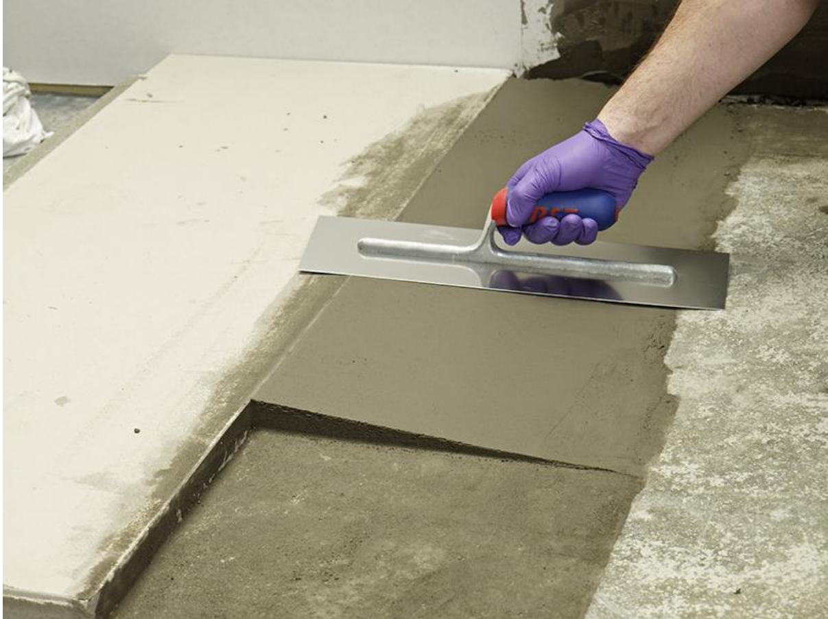
Εικόνα 3-21: Εφαρμογή επισκευαστικού κονιάματος
