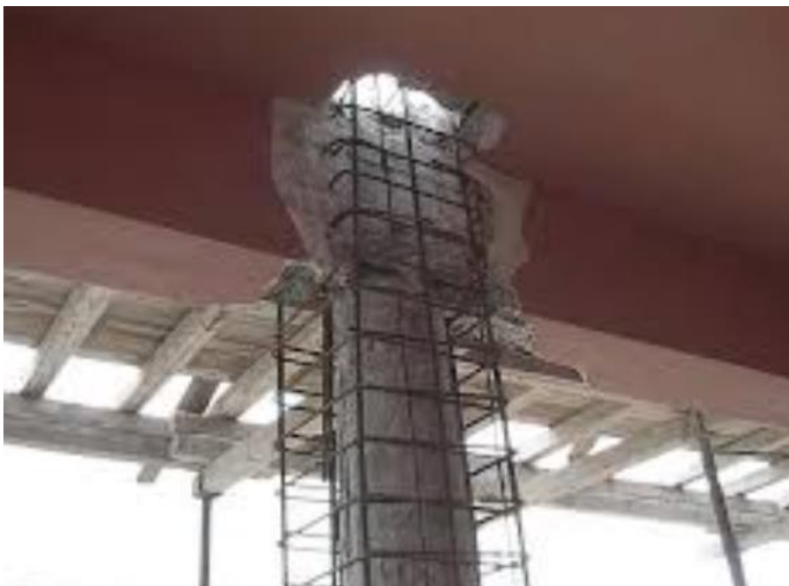
Εικόνα 3-31: Επέκταση του μανδύα υποστυλώματος στον παραπάνω όροφο
