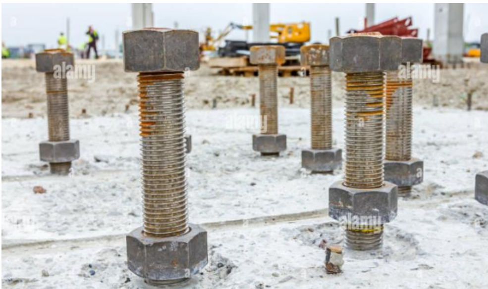
Εικόνα 3-16: Στις οπές κοχλιών αγκυρώσεις που διανοίχθηκαν μετά τη σκυροδέτηση γίνεται χρήση διογκούμενου σκυροδέματος για την πλήρωση τους
