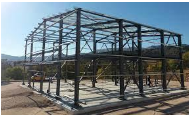
Εικόνα 2-41: Βιομηχανικό μεταλλικό υπόστεγο με πλάκα σκυροδέματος επί εδάφους [23]
