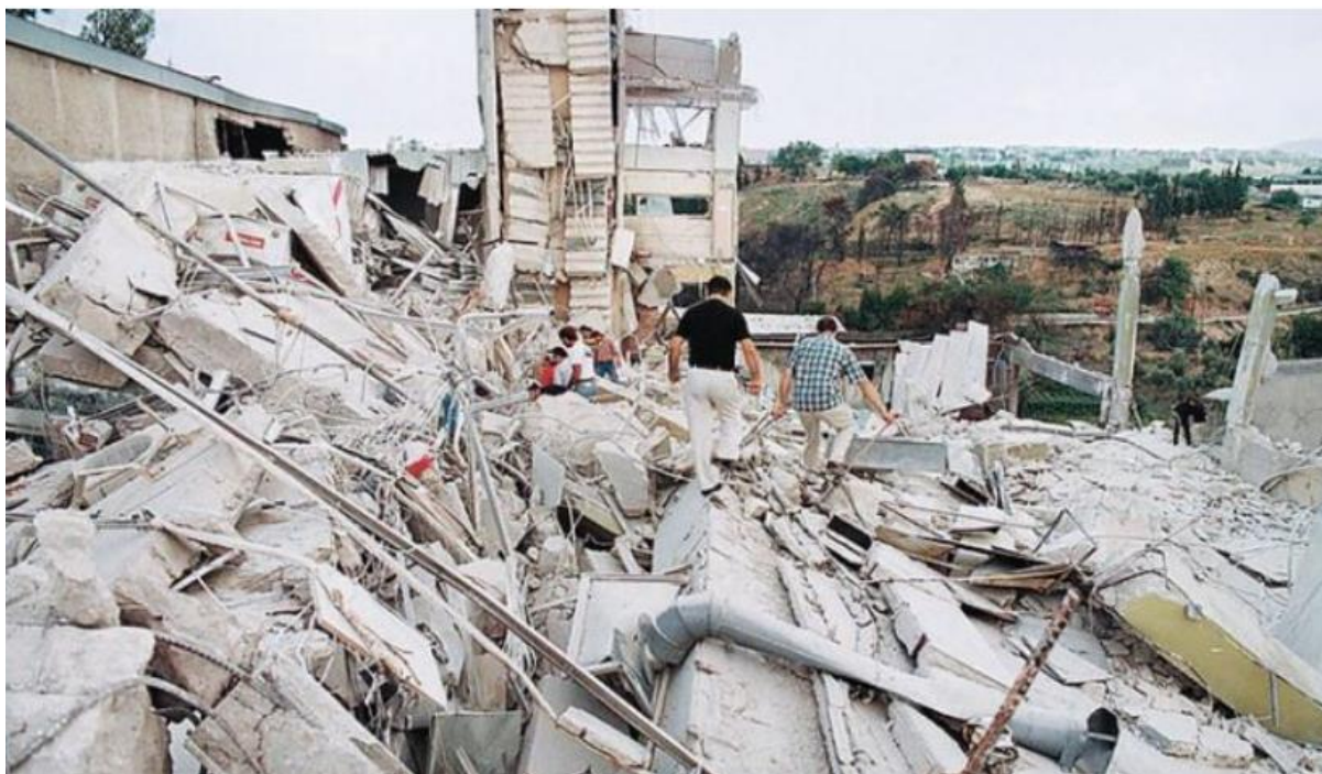
Εικόνα 2-14: Κατάρρευση εργοστασίου Ρικομέξ στο σεισμό της Αθήνας το 1999 με βασικό παράγοντα τα κοντά υποστυλώματα
