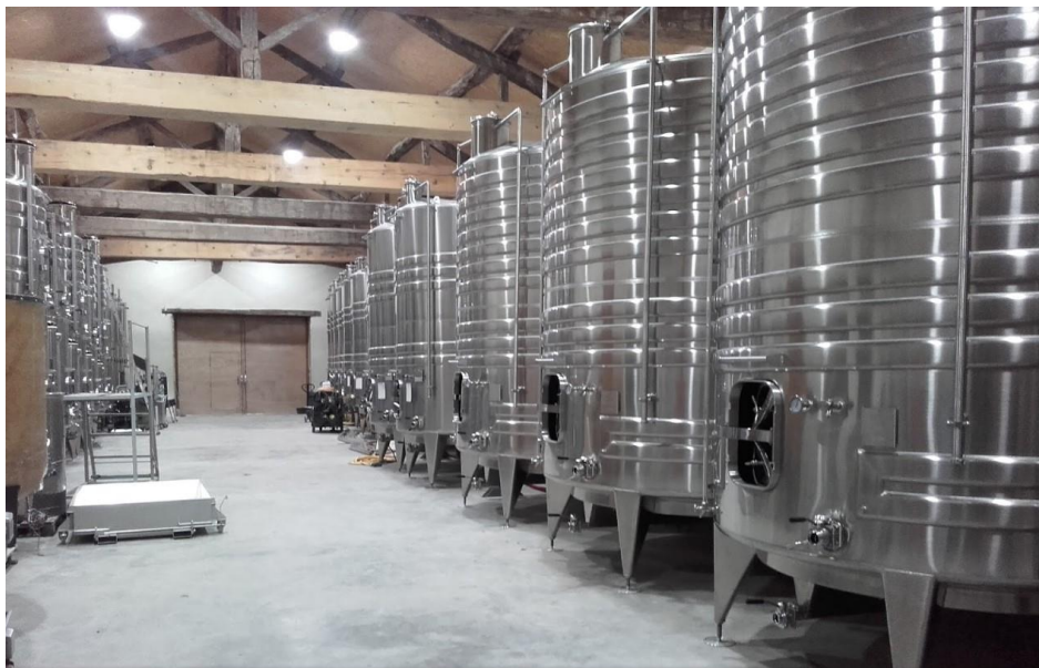
Εικόνα 3.15 Δεξαμενές Ζύμωσης (φωτ. αρχείο από το οινοποιείο «Πύργος Βασιλίσσης»)
