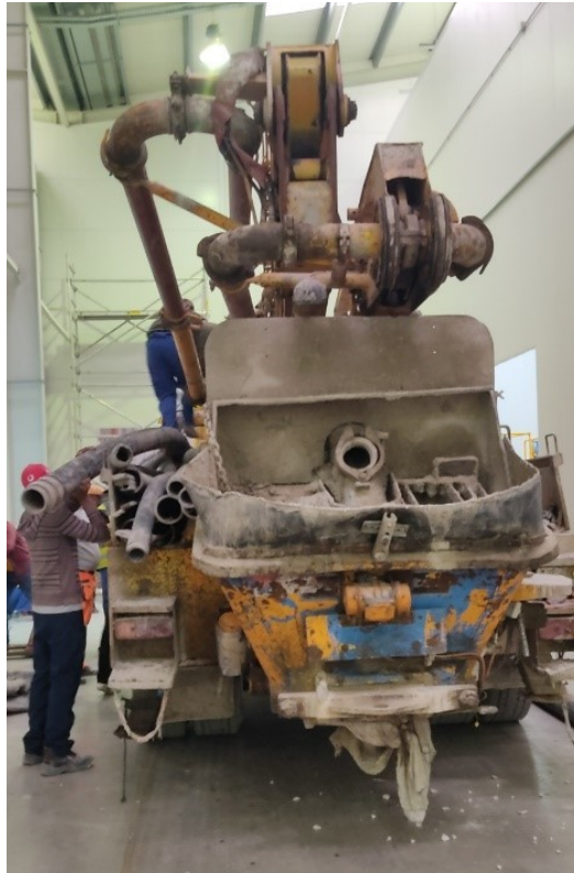
Εικόνα 9.2: Μηχάνημα με τη βοήθεια του οποίου γίνεται η σκυροδέτηση.
