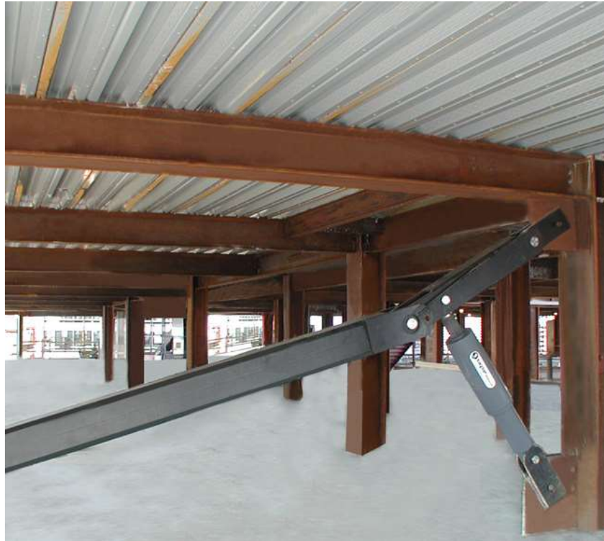
Εικόνα 4.7 Εναλλασσόμενος ιζώδης αποσβεστήρας (Toggele)
