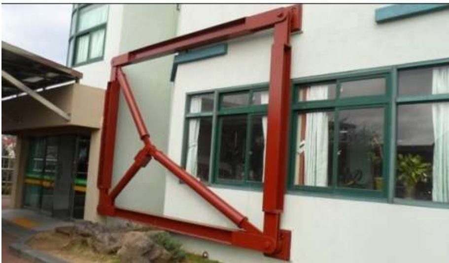
Εικόνα 7.5 εξωσκελετός σε υφιστάμενο κτίριο καθώς και αποσβεστήρας. Ο εξωσκελετός έχει ακυρωθεί τοπικά στην συμβολή υποστυλωμάτων και δοκών με μεταλλικές φλάντζες.
