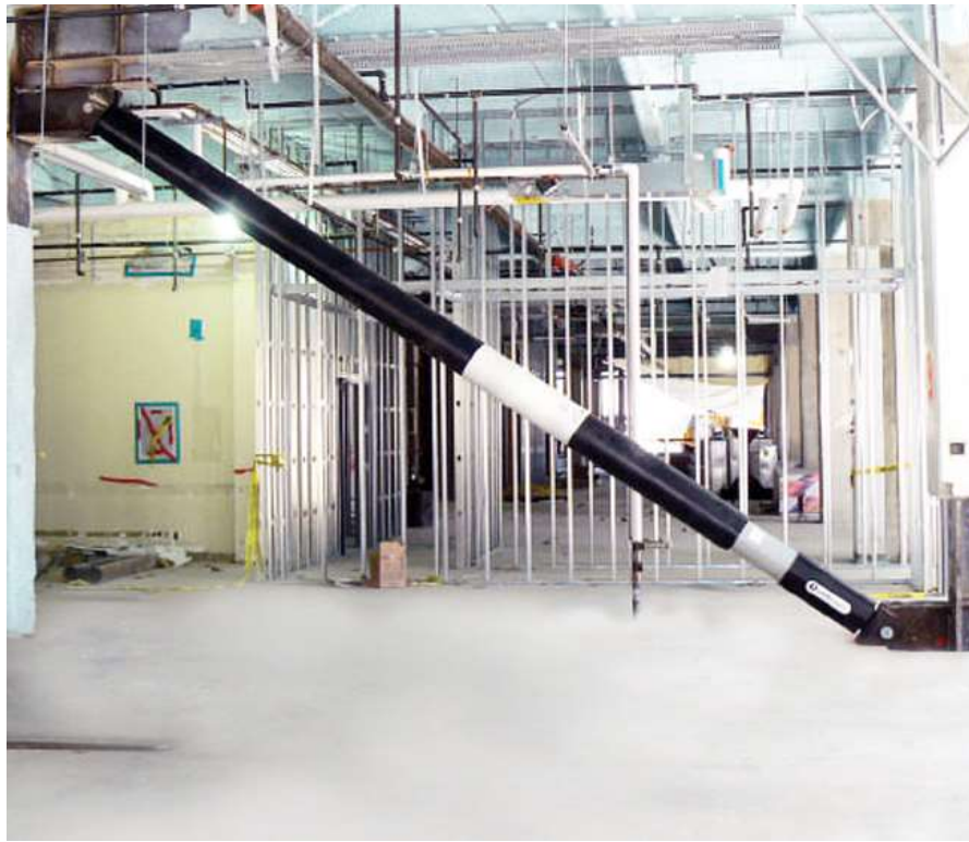
Εικόνα 4.4 Διαγώνιος ιζώδης αποσβεστήρας
