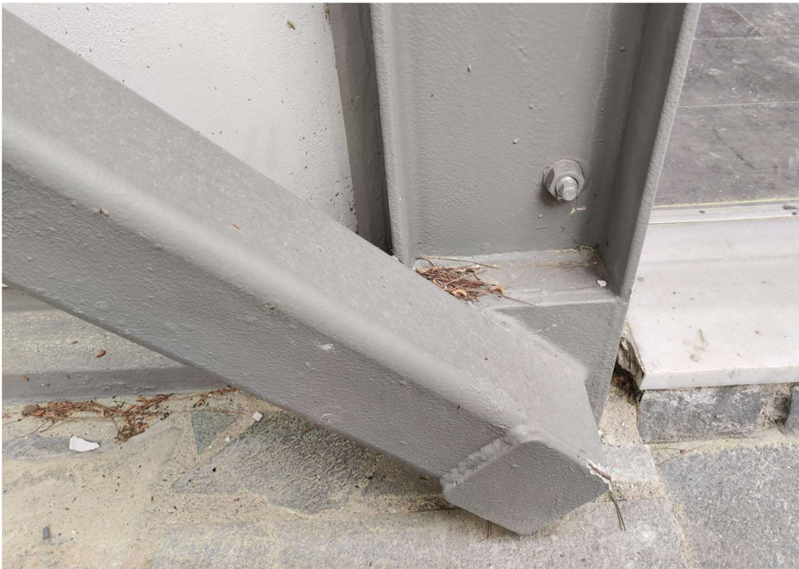
Εικόνα 7.4 εξωσκελετός σε υφιστάμενο κτίριο. Διακρίνεται η ένωση των διαγώνιων στοιχείων με τα κάθετα και τα κατακόρυφα καθώς και η αγκύρωση του μεταλλικού στοιχείου στην θεμελίωση. Στην προκείμενη περίπτωση έχει επιλεγεί η ηλεκτροσυγκόλληση.
