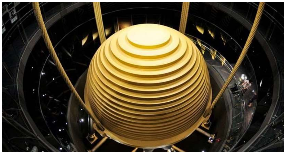
Εικόνα 3.1 Αποσβεστήρας συντονισμένης μάζας
