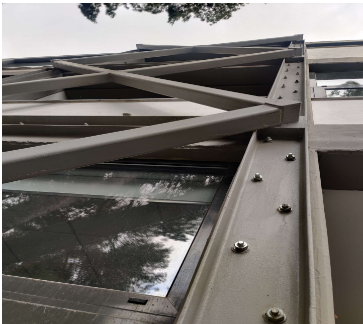
Εικόνα 7.1 εξωσκελετός σε υφιστάμενο κτίριο αγκυρωμένος επί στοιχείων ωπλισμένου σκυροδέματος με χημικά βύσματα.
