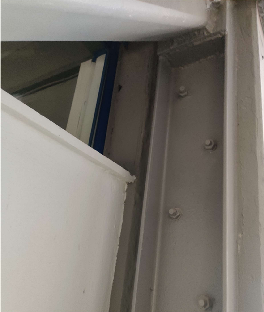
Εικόνα 7.3. εξωσκελετός σε υφιστάμενο κτίριο. Διακρίνεται η ένωση των διαγώνιων στοιχείων με τα κάθετα και τα κατακόρυφα. Στην προκείμενη περίπτωση έχει επιλεγεί η ηλεκτροσυγκόλληση.
