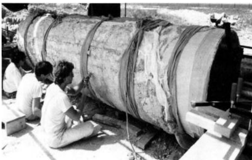
Εικόνα 3-24: Καθαρισμός της πίσω όψης του ψηφιδωτού και αφαίρεση υπολειμμάτων κονιάματος με σφυρί και σμίλες, (1991), P. Pastorello.
