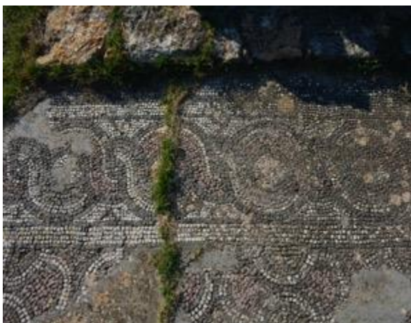
Εικόνα 3-2: Ανάπτυξη ριζικών συστημάτων εντός των υποστρωμάτων και στην επιφάνεια του ψηφιδωτού στο Νότιο Κλίτος της Παλαιοχριστιανικής Βασιλικής στην Αγία Τριάδα, (2018), Συνεργείο Συντήρησης Ψηφιδωτών.
