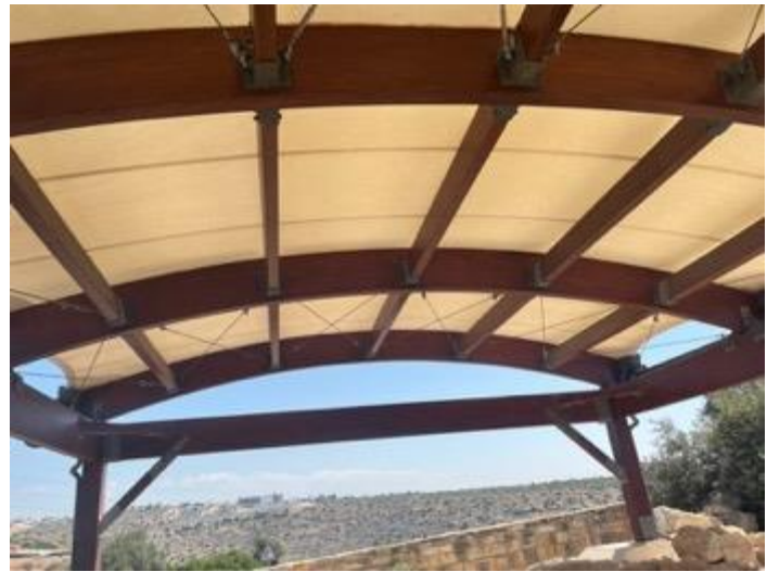
Εικόνα 3-46: Στέγαστρο με τόξα, δοκούς και μεμβράνες της Οικίας του Αχιλλέα, (2017), Α. Λουκαΐδου.
