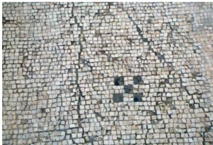
Εικόνα 3-7: Ανάπτυξη μυκήτων από υπολείμματα οργανικής κόλλας στο Γεωμετρικό ψηφιδωτό της Κεντρικής Αυλής στην Οικία Μονομάχων στο Κούριο, (2006), Συνεργείο Συντήρησης Ψηφιδωτών.
