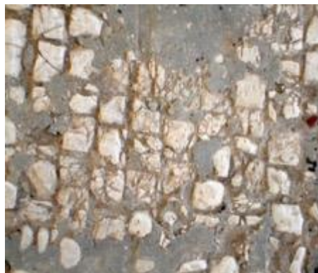
Εικόνα 3-31: Ρηγματώσεις και αποφλοιώσεις ψηφίδων λόγω περιμετρικής στερέωσης με τσιμεντοκονίαμα στο Γεωμετρικό ψηφιδωτό της Κεντρικής Αυλής στην Οικία Μονομάχων στο Κούριο, (2006), Συνεργείο Συντήρησης Ψηφιδωτών.
