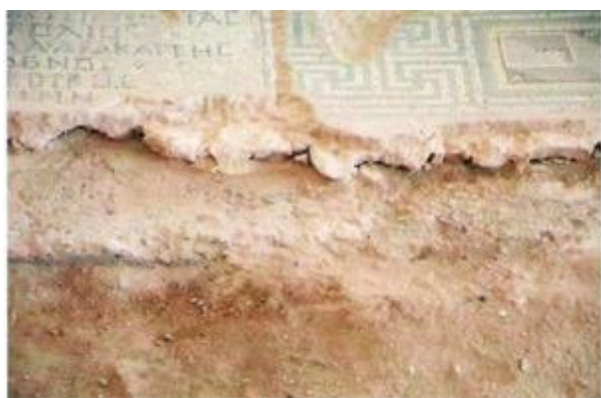
Εικόνα 3-15: Υποστρώματα με τσιμεντοκονίαμα στο ψηφιδωτό της Ανατολικής Στοάς της Οικίας Ευστολίου στο Κούριο, (2004), Συνεργείο Συντήρησης Ψηφιδωτών.
