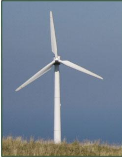
Εικόνα 16: Ανεμογεννήτρια οριζόντιου άξονα (Λειβαδάρας, 2016).
