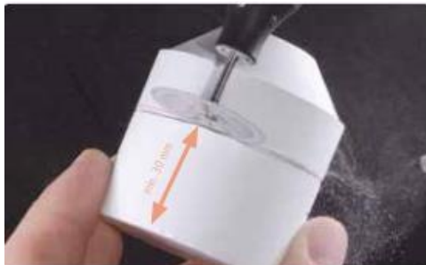
(Εικ.86) Ο δακτύλιος σημειώνεται 30 mm από την βάση του και κόβεται με δίσκο. (67)
