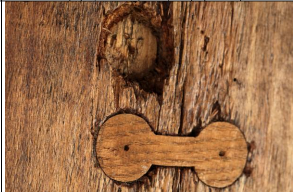
Εικόνα 3. 43: Ένθετος ξύλινος σύνδεσμος στο πίσω μέρος.
