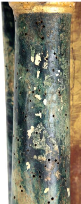
Εικόνα 2. 10: Οπές από ξυλοφάγα έντομα στους κιονίσκους. Πηγή: Προσωπικό αρχείο
