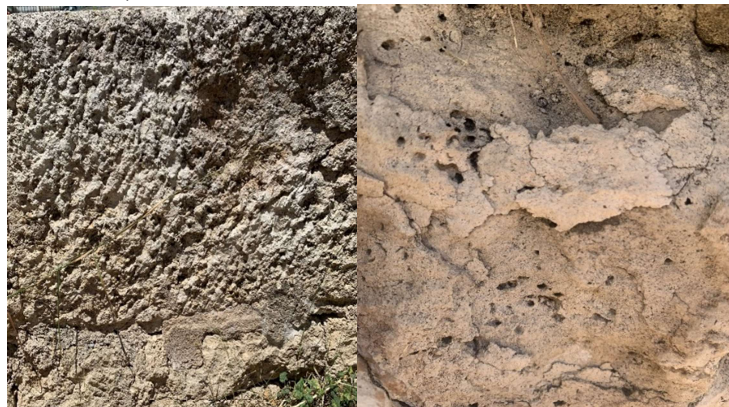
Εικόνα 5.18β. Διάτρηση.
