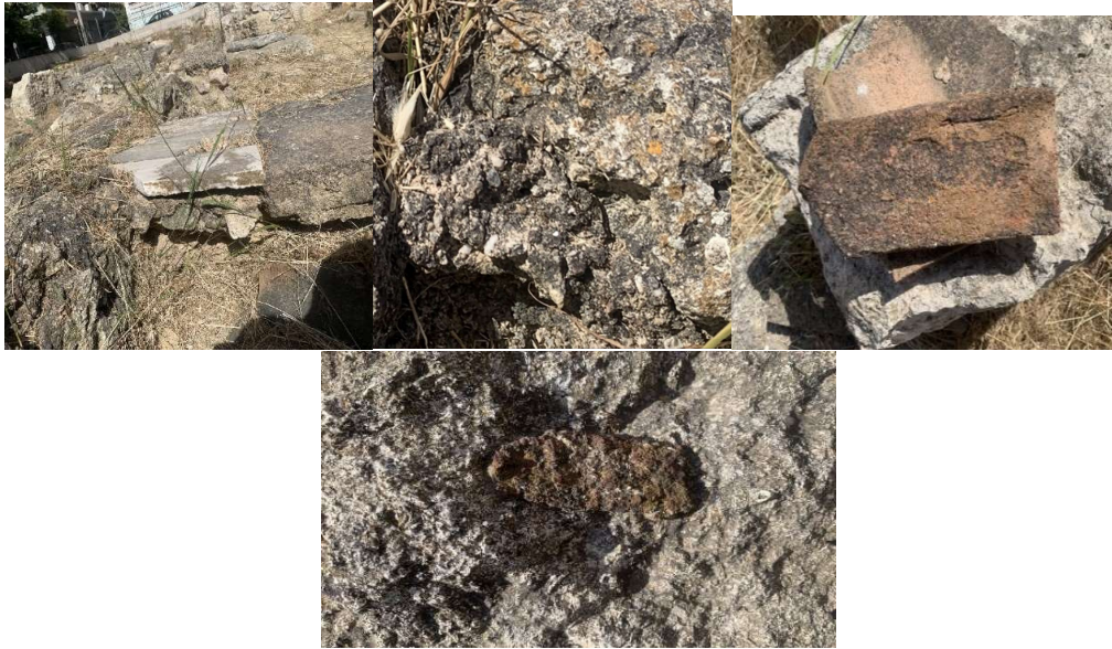
Εικόνα 5.23. Βιοδιάβρωση.
