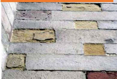
Εικόνα 5.10. Αποφλοιώση/απολέπιση.
