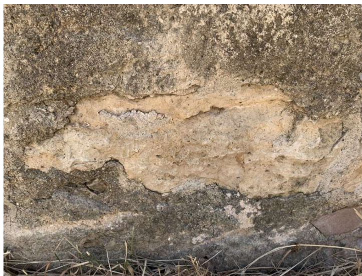
Εικόνα 5.9. Αποφλοίωση.
