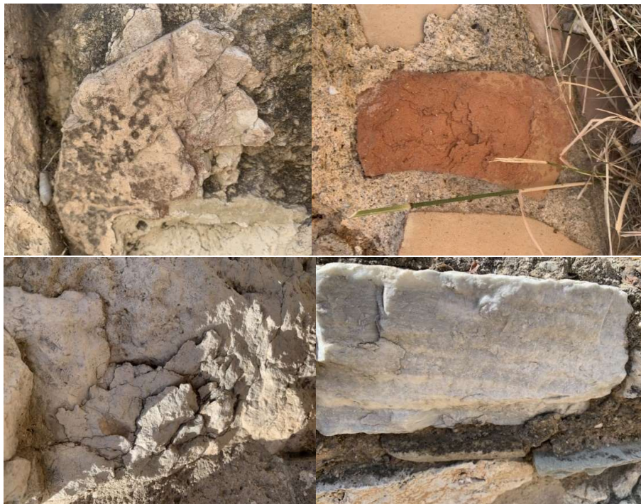
Εικόνα 5.11. Αποφλοιώση/Απολέπιση/Αποσάθρωση.
