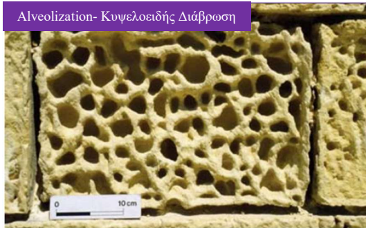
Εικόνα 5.12. Κυψελοειδής διάβρωση.
