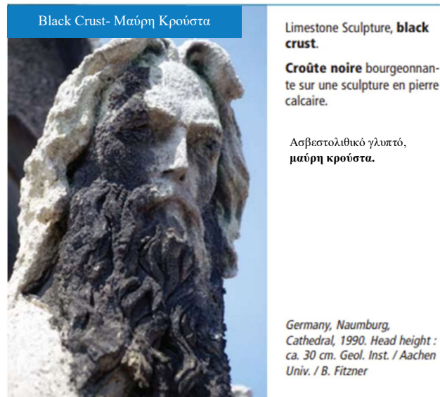
Εικόνα 5.20. Χρωματικές αλλοιώσεις και αποθέσεις.
