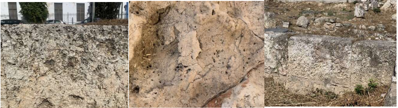
Εικόνες 5.13. Τα φαινόμενα της Αποφλοίωσης, Αποσάθρωσης, Απολέπισης, Κυψελοειδούς Φθοράς, εμφανίζονται σε μεγάλη ένταση και στην πλειονότητα των περιπτώσεων παρατηρείται παράλληλη παρουσία τους.
