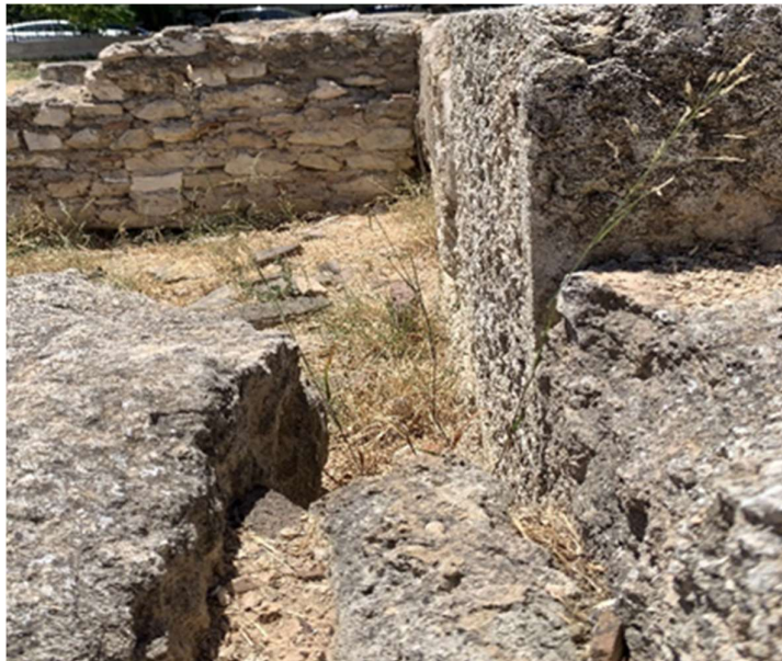
Εικόνα 5.7. Διαφορική διάβρωση.
