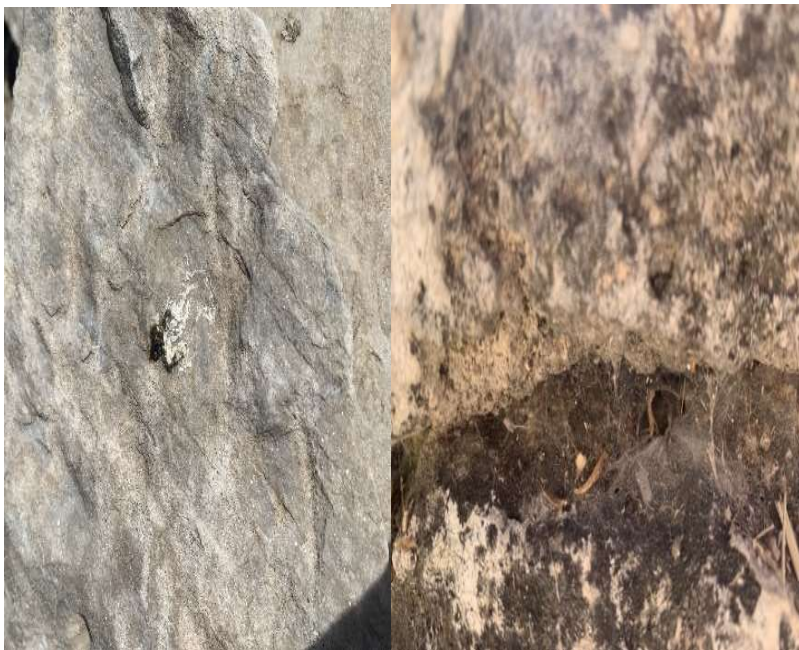
Εικόνα 5.24. Βιοδιάβρωση.
