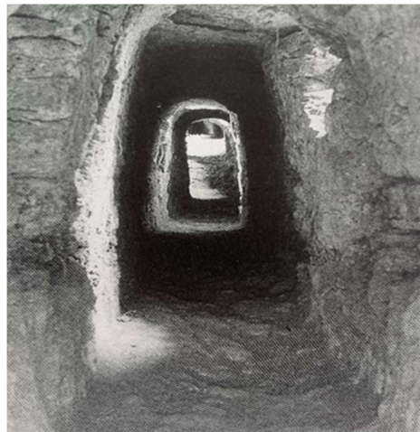
Εικόνα 2.15. Ο παράλληλος προς την οδό Σκουζέ αποχετευτικός αγωγός. Πηγή: Αξιώτη, 2009.
