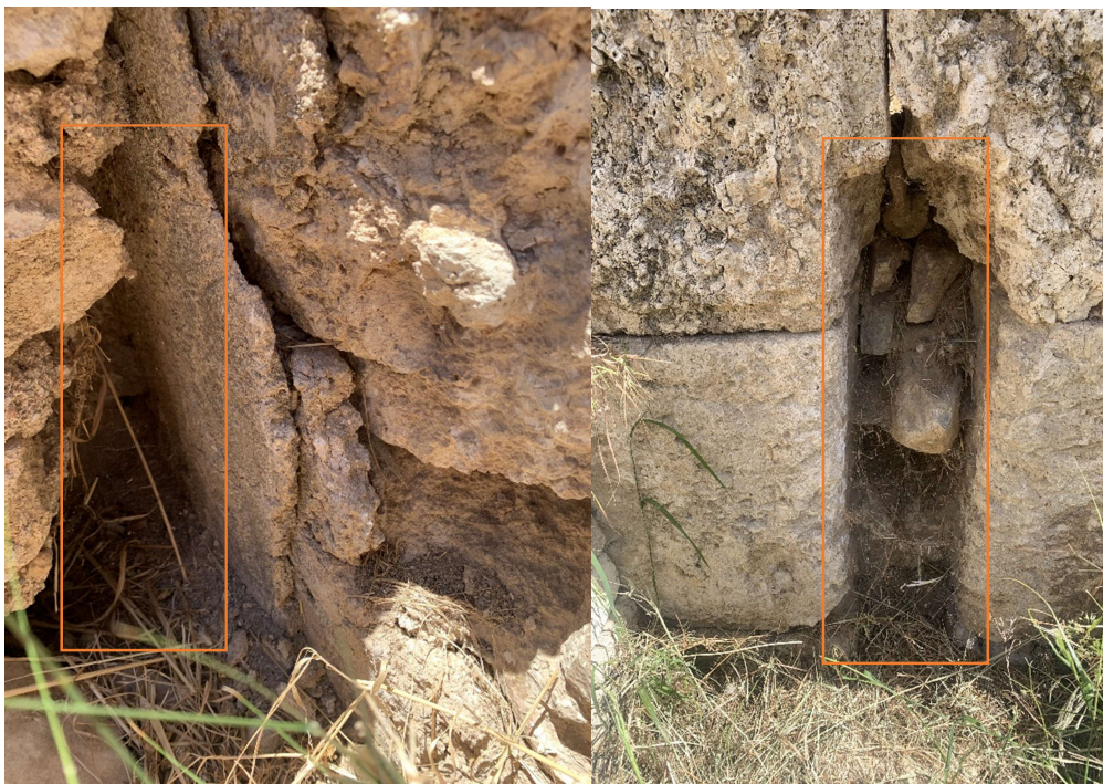
Εικόνες 5.17. Απώλεια Υλικού –Ελλείπον τμήμα.
