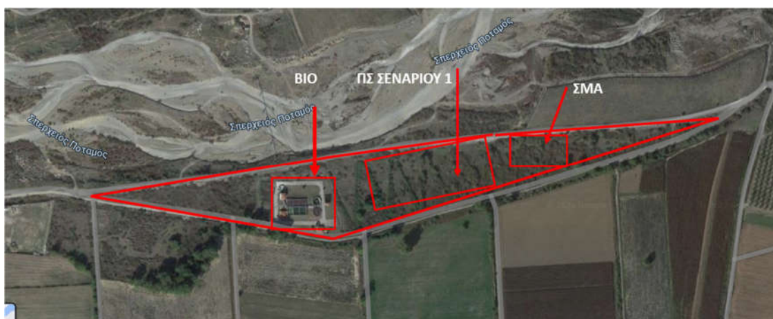
Εικόνα 11: Τοποθεσία κατασκευής Σεναρίου 1
