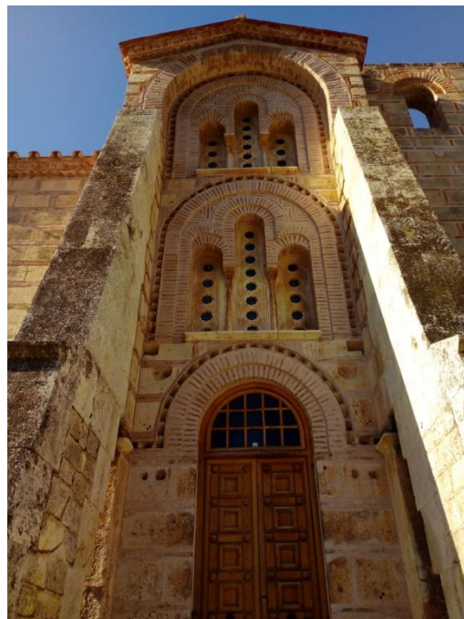
Εικόνα 2.14 Κεραμοπλαστικός διάκοσμος περιμετρικά των τρίλοβων παραθύρων και στο τύμπανο της θύρας στη βόρεια όψη του Καθολικού
