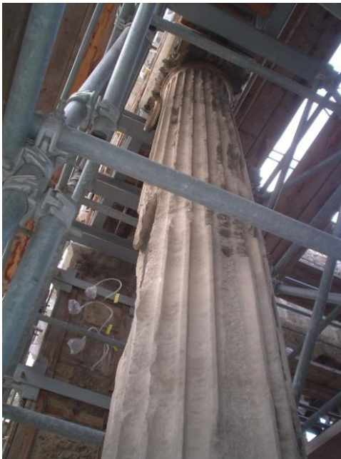
Εικόνα 1.15 Ιωνικός κίονας κατά τη διάρκεια της επισκευής μετά το σεισμό του 1999
