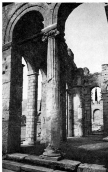
Εικόνα 1.12 Δίλοβο άνοιγμα της νότιας πλευράς του εξωνάρθηκα με την αναστήλωση
