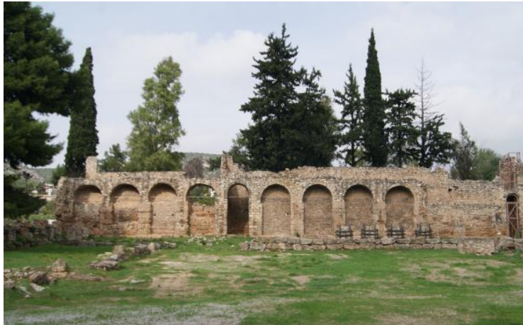
Εικόνα 1.20 Περίβολος της Μονής Δαφνίου πριν το σεισμό του 2019
