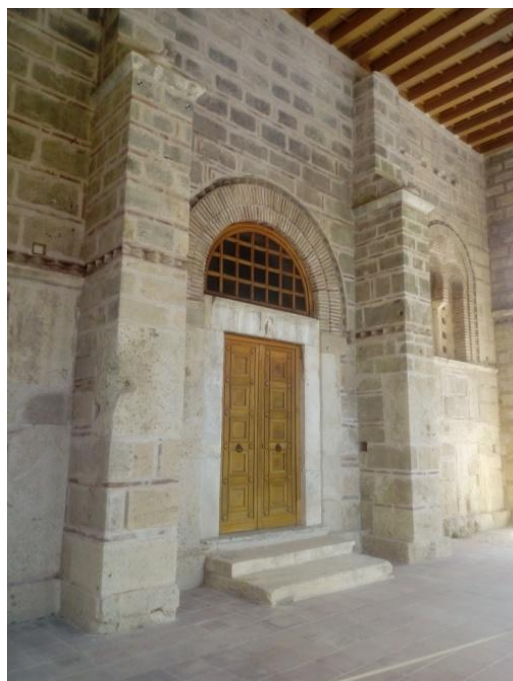
Εικόνα 2.7 Τύμπανο ανάμεσα στο υπέρθυρο και το τόξο της θύρας με πλαίσιο από μάρμαρο
