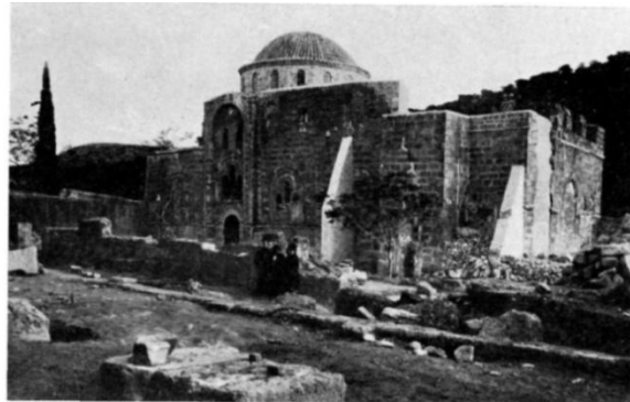
Εικόνα 1.11 Βορειοδυτική Όψη του Καθολικού μετά την αναστήλωση
