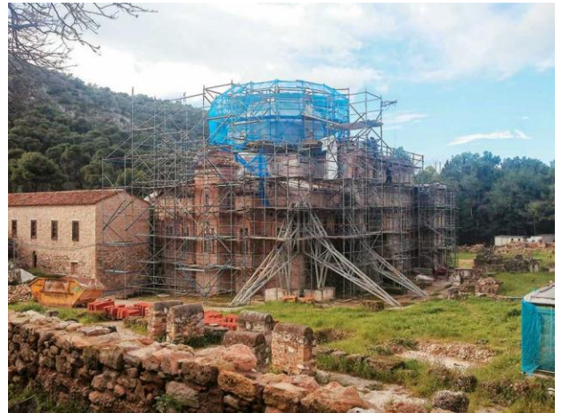
Εικόνα 1.14 Το Καθολικό της Μονής κατά τη διάρκεια της επισκευής μετά το σεισμό του 1999
