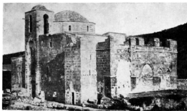
Εικόνα 1.10 Βορειοδυτική Όψη του Καθολικού πριν την αναστήλωση ( Φωτογραφία Γ.Λαμπάκη)
