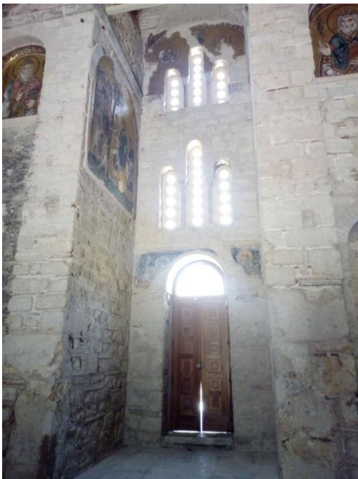
Εικόνα 2.4 Πλάγιος κλίτος και θύρα βόρειας πλευράς
