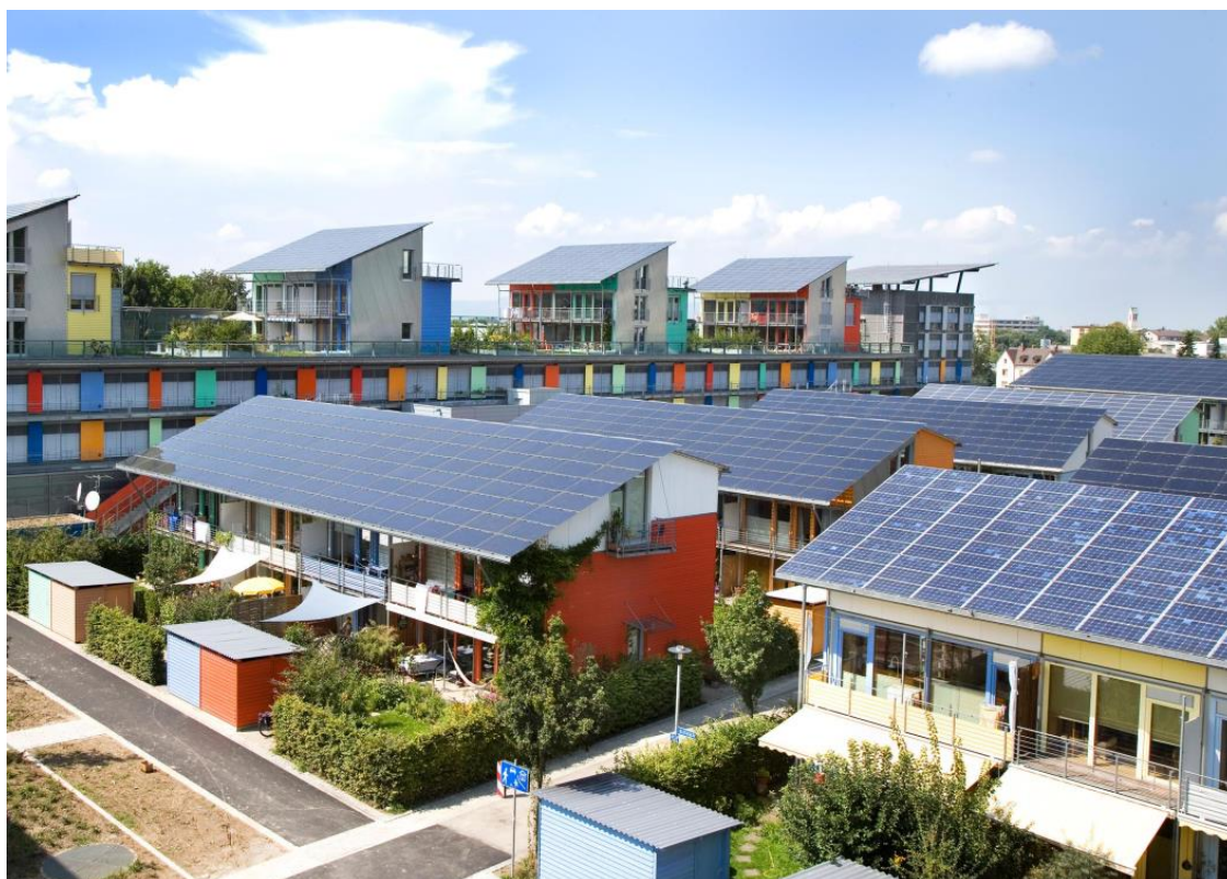
Εικόνα 32 Ολοκληρωμένο σύστημα άντλησης ενέργειας, φωτοβολταϊκών, Γερμανία, 2002 Πηγή: https://en.wikipedia.org/wiki/Photovoltaics#/media/File:SoSie+SoSchiff_Ansicht.jpg
