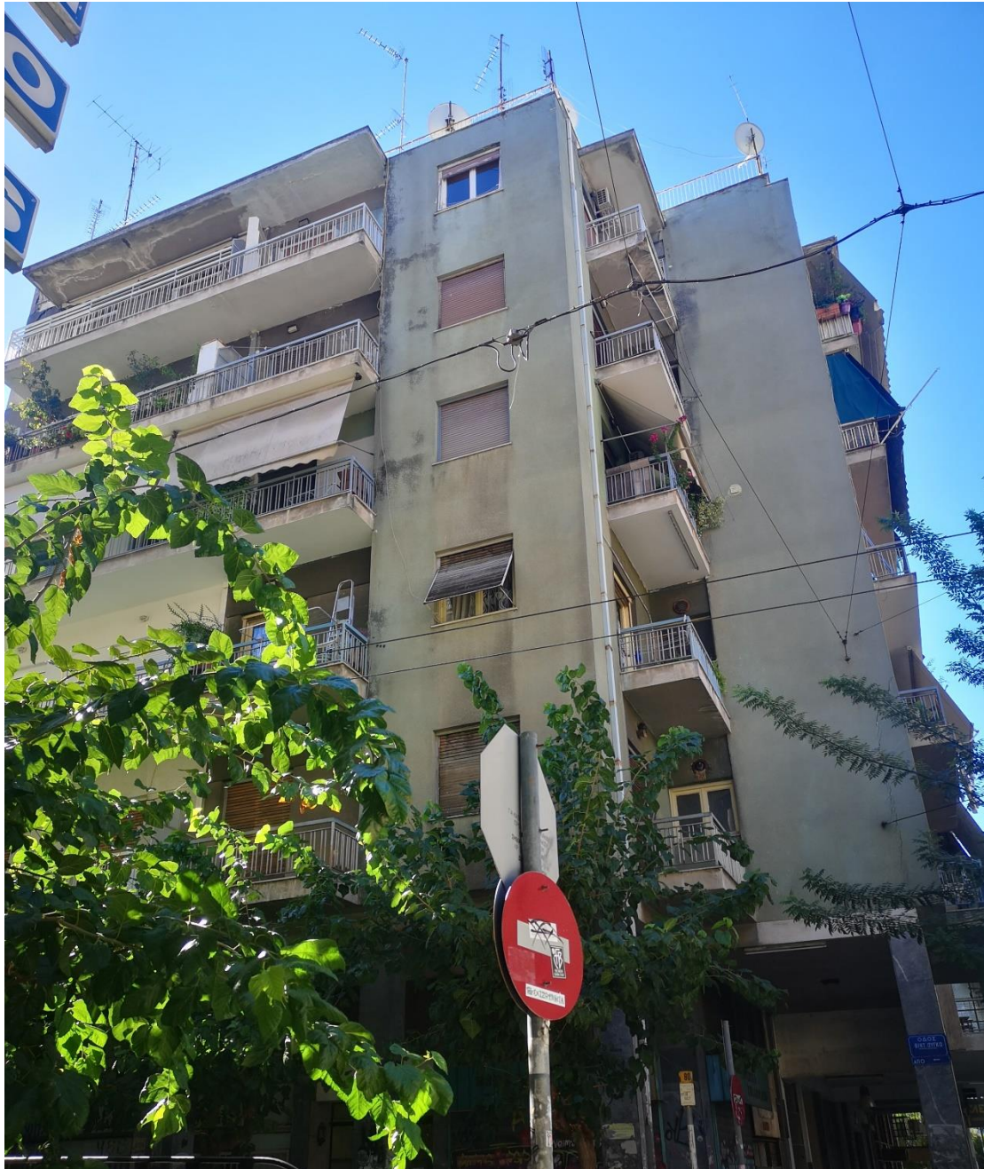
Εικόνα 6 Πολυκατοικία Μεταξουργείο, οδός: Ακομινάτου Πηγή: Συγγραφέας
