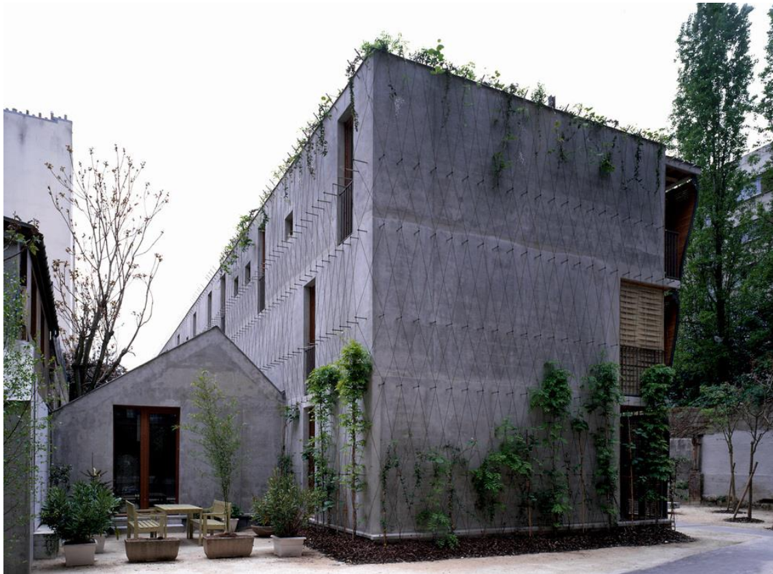
Εικόνα 57 Εσωτερικό κτιριακό συγκρότημα πίσω όψη Πηγή: zip thtreemag.com
