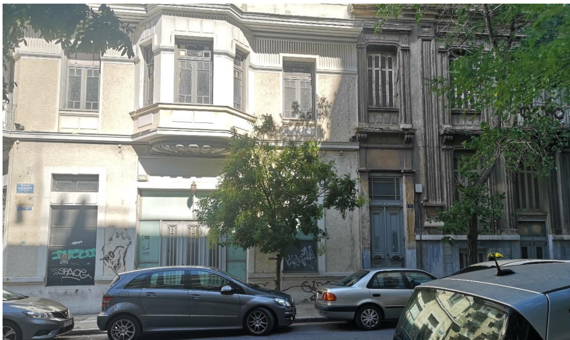
Εικόνα 2 Εγκαταλελειμμένα νεοκλασικά κτίρια, Οδός Οδυσσέως, Πηγή: Συγγραφέας
