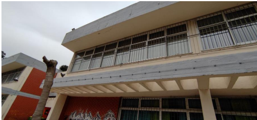
Εικόνα 1: Ανατολική όψη με λεπτομέρειες προβόλων.
