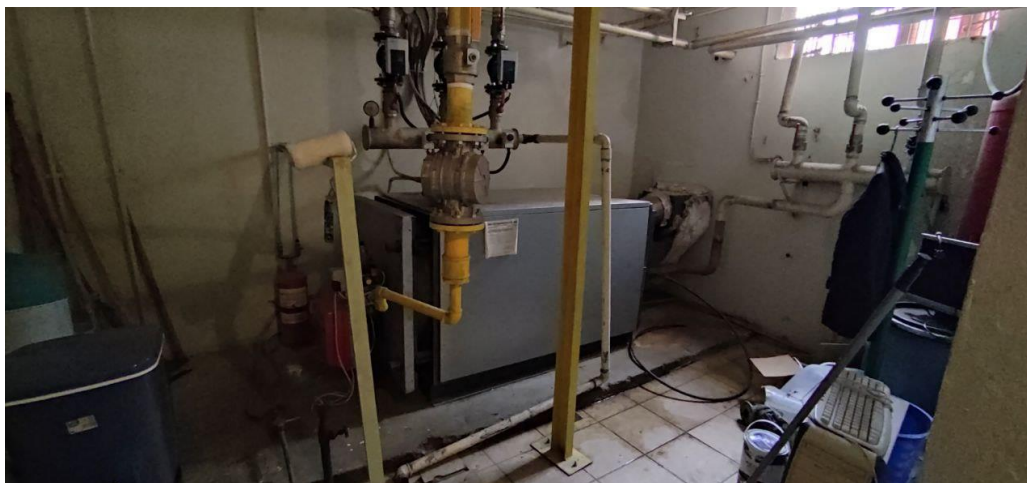
Εικόνα 29: Χαλύβδινος Λέβητας Φυσικού Αερίου (rayon).
