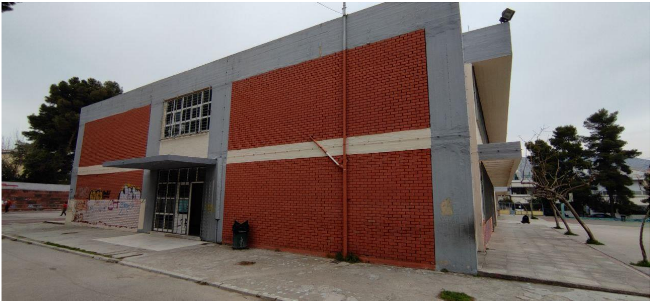
Εικόνα 8: Νοτιά όψη του κτιρίου.
