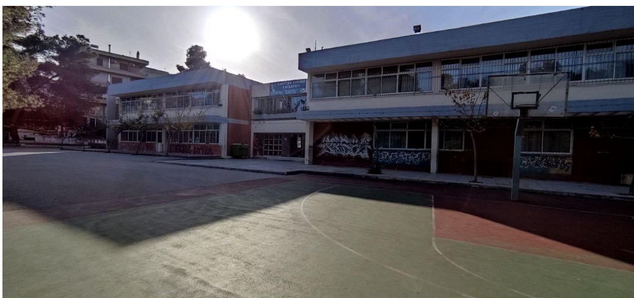
Εικόνα 7: Ανατολική όψη του κτιρίου.
