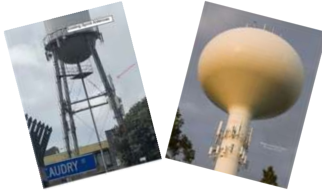
Εικόνα 45: Μικρές Κυψέλες που φιλοξενούνται σε Δεξαμενές Νερού.
