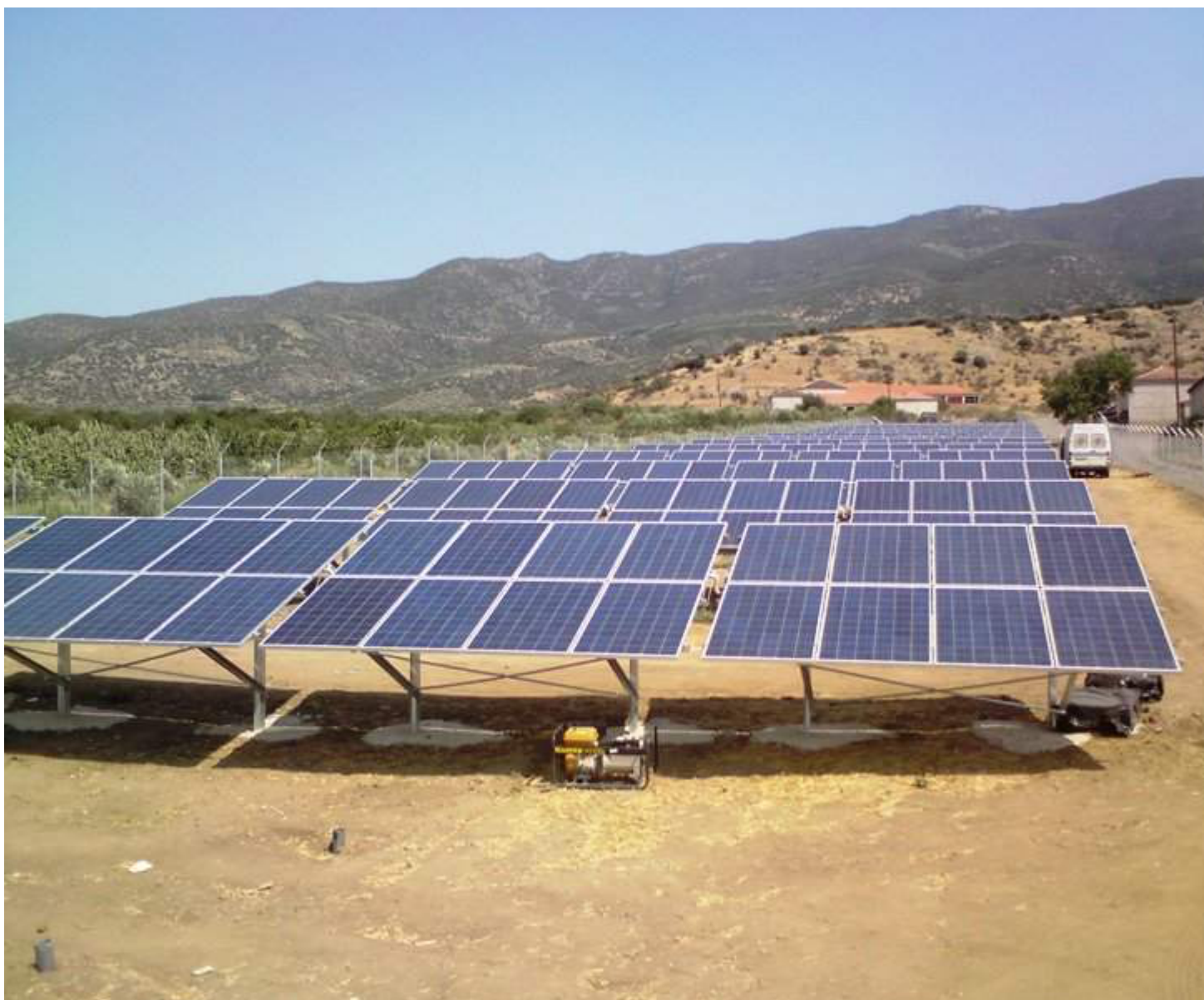
Εικόνες 11 και 12: Φωτοβολταϊκό πάρκο 100kWp στην Αγιά Λάρισα
