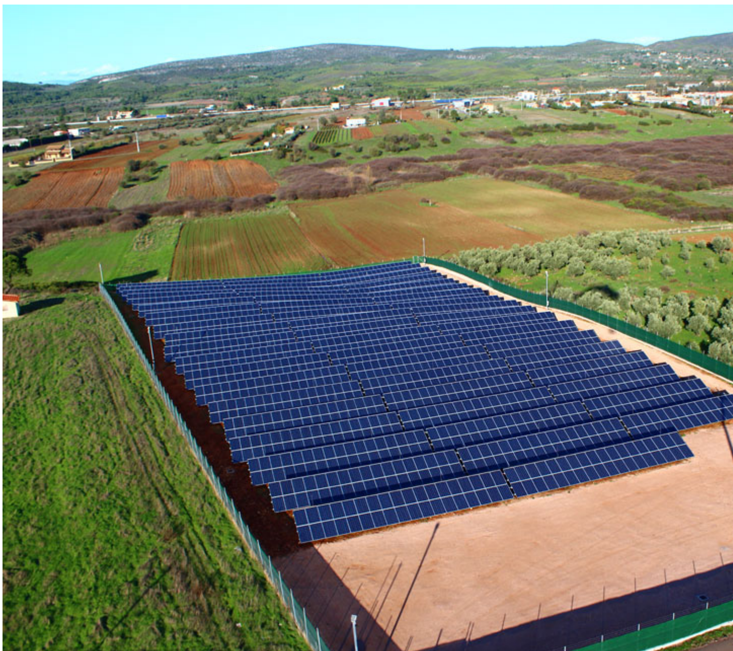
Εικόνα 13:Φωτοβολταϊκό πάρκο 500kwp στον Αυλώνα Αττικής
