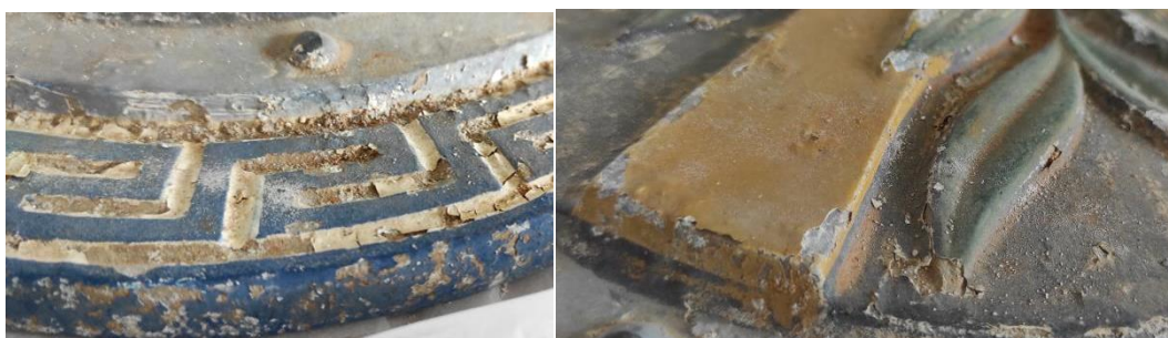
Εικόνα 51: Επικαθίσεις, αποκόλληση, κύρτωση κα απώλεια χρωματικού στρώματος στη Βοιωτική ασπίδα.
