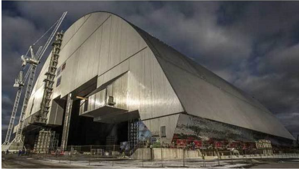
Εικόνα 1. Απεικόνιση του New Safe Confinement (NSC) με τη μονάδα 4 του Τσερνόμπιλ πίσω του. Η δομή των 36.000 τόνων ωθήθηκε 327 μέτρα σε σιδηροτροχιές στη θέση του πάνω από το κτίριο του αντιδραστήρα τον Νοέμβριο του 2016. (Ευρωπαϊκή Τράπεζα Ανασυγκρότησης και Ανάπτυξης)
