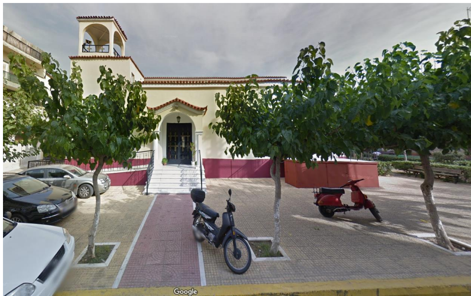
Εικόνα 17: Ζωοδόχου Πηγής (Πηγή: Google Maps)
